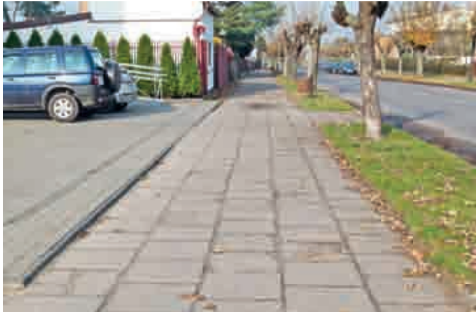
W ramach budżetu obywatelskiego wyremontowany ma zostać chodnik przy ul. Kopernika.
