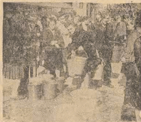
gdy brak wody w wyżej wymienionym rejonie (a zdarza to się nader często) nieszczęśliwi mieszkańcy muszą się tłoczyć z wiaderkami przy hydrancie ulicznym, który tylko jeden kurek posiada.
