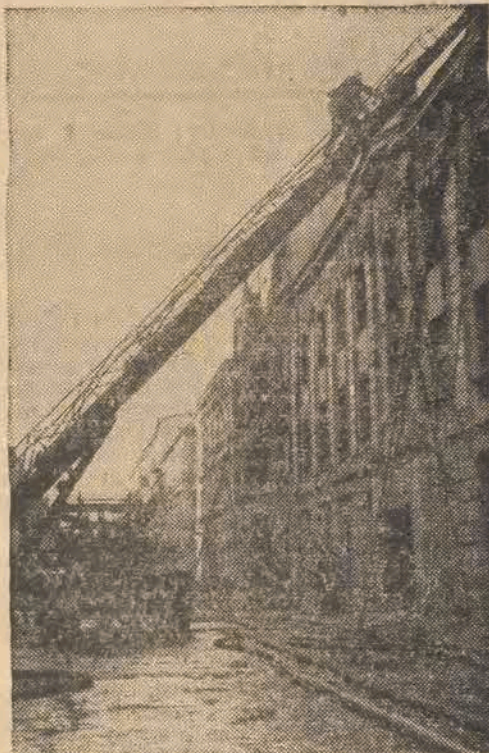
Do 1 października b. r., Łódzka Straż Ogniwa musiała interweniować aż w 298 katastrofach budowlanych. Jak z tego wynika, katastrofy budowlane są w Łodzi znacznie większą plagą od pożarów. Dobrze, że strażacy nas nie upierają się przy swej zasadniczej specjalności i spieszą ofiarnie również na alarm: DOM SIĘ WALI!
