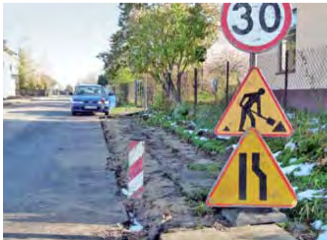
Chodnik na ul. Szkolnej został już zdjęty, wkrótce zostanie zastąpiony betonową kostką.
