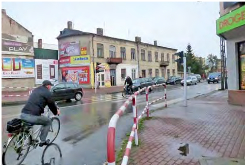
Ulica Kurkowa zostanie przebudowana i poszerzona tak, że w sumie powstaną na niej 4 pasy ruchu. Widoczna na zdjęciu kamienica zostanie zburzona.
