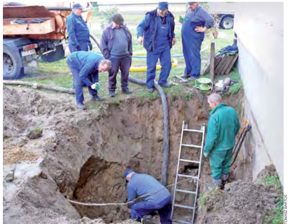
Wymiana przyłącza wodociągowego przy bloku nr 42 na os. Bratkowice spowodowała okresowy brak wody u mieszkańców.
