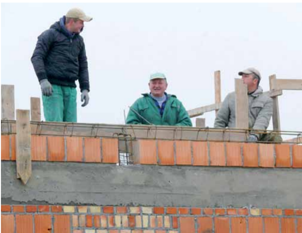
Jest ciepło, więc z budowy nie trzeba uciekać. Dach może być przed zimą.
