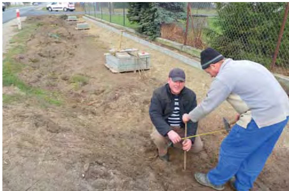
Pracownicy firmy Budmel mają nadzieję skończyć z pracami do połowy grudnia. Wiele zależy od warunków atmosferycznych.
