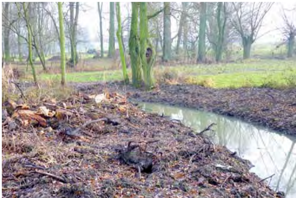
Przez kilka dni drzewa, które zostały wycięte leżały nad brzegiem rzeki. Firma uporządkowała teren dopiero w ostatnich dniach.
