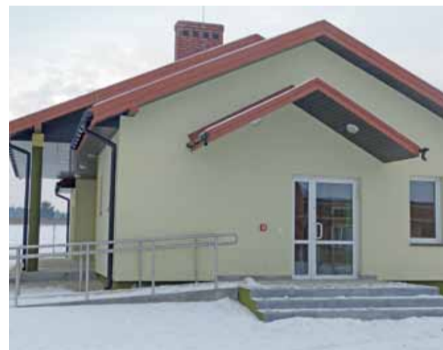
Do nowego budynku w Dąbkowicach Górnych wykonano także podjazd dla osób niepełnosprawnych.
