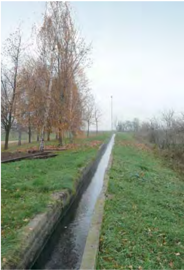
Kanał odprowadzający wodę z oczyszczonych ścieków na stawy. Po modernizacji zostanie zastąpiony przez rurociąg.
