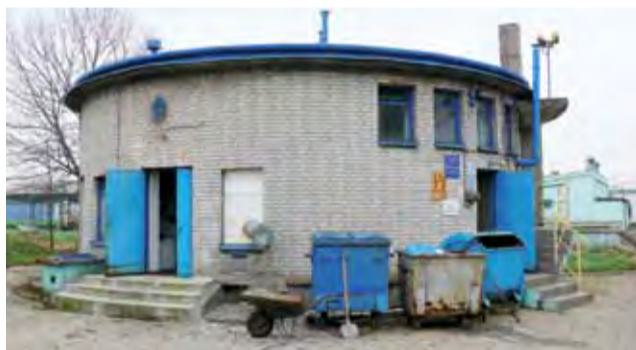
Przepompownia ścieków znajdująca się na samym wejściu na teren oczyszczalni.
