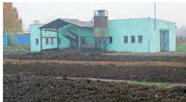
Budynek obecnej suszarni, gdzie osady są poduszane, a następnie wyrzucane na zewnątrz w celu kompostowania.
