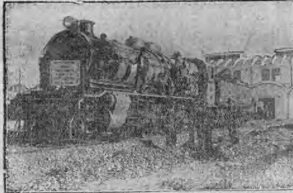
Ostatnio Polska wysłała do Maroka 12 lokomotyw krajowej produkcji. Na zdjęciu widzimy jedną z wystanych lokomotyw na miejscu przeznaczenia, na stacji Ouadja w Maroko.
