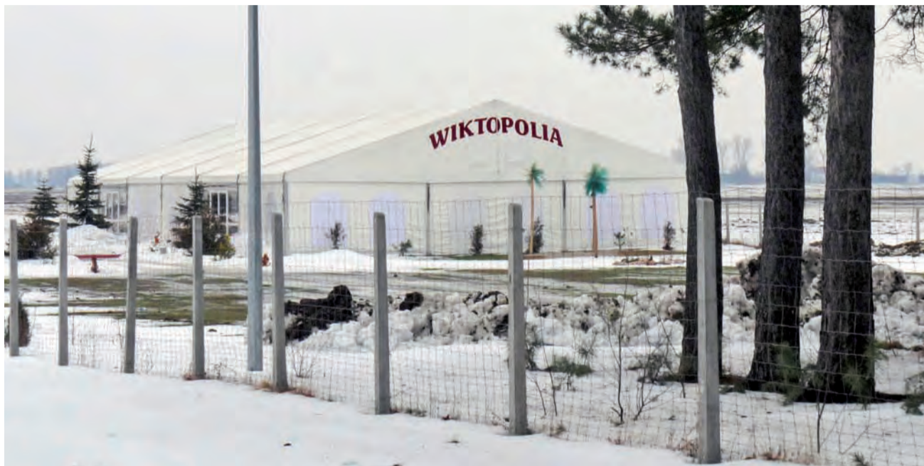
Namiot w Strzelcewie sąsiaduje z lasem. Kilkanaście drzew rośnie już na terenie weselnej posesji.
