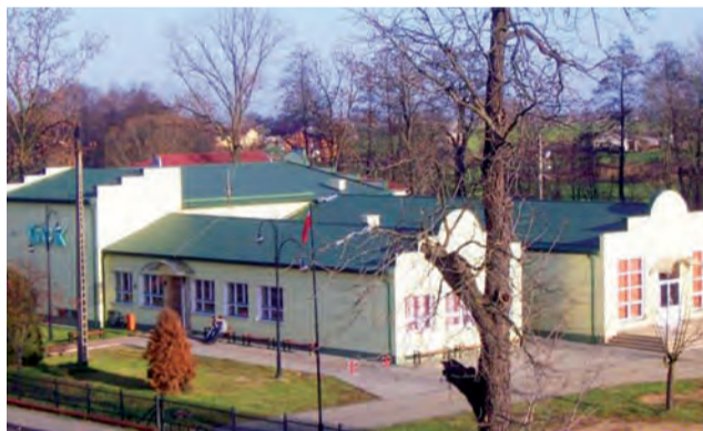
W ośrodku w Łyszkowicach wymienione zostały okna, poprawiona została kanalizacja, a obok rozpoczęła się budowa muszli koncertowej.
