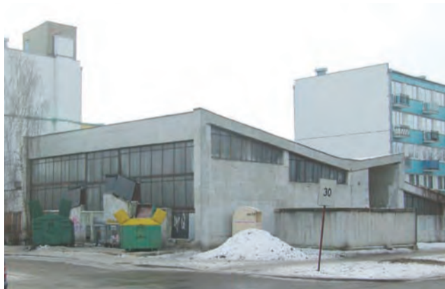
Po zdemontowaniu kominów przy miejskich kotłowniach, budynki te będą oczyszczane ze znajdujących się tam urządzeń grzewczych.
