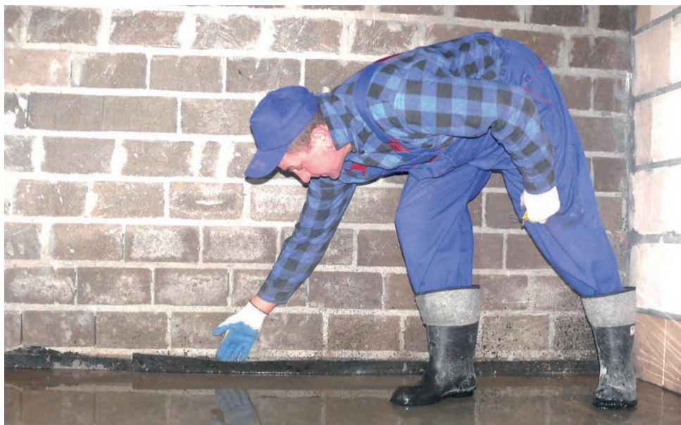
Pracownik skierniewickiej firmy Insbud pokazuje izolację podpiwniczenia, która powinna chronić przed dostawaniem się wody do środka budynku.
