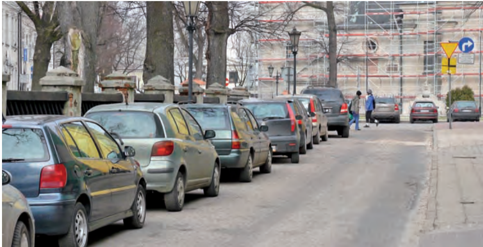
W tym roku na ul. Pijarskiej planowane jest tylko wykonanie kanalizacji, nawierzchnia nie jest planowana.
