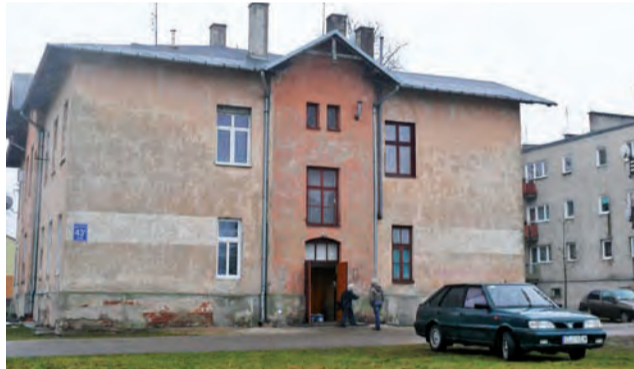
Budynek 43i na osiedlu Armii Krajowej jeszcze w tym roku zmieni swój wygląd.
