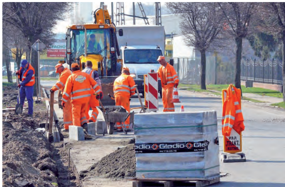
Prace na ul. Katarzynów w Łowiczu, prowadzi kutnowska firma Trakt, która zajmowała się już w naszym mieście modernizacją ul. 3 Maja, czy budową ul. Starorzecze.
