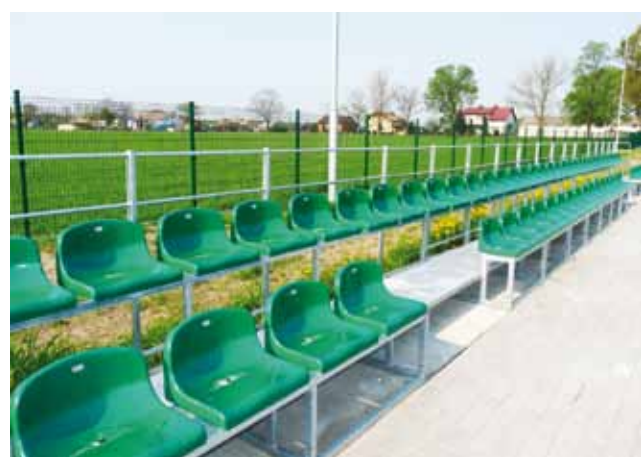
Krzesła i biegnący przy nich chodnik zostały już wykonane przez firmy, które pracowały przy budowie kompleksu w ubiegłym roku.
