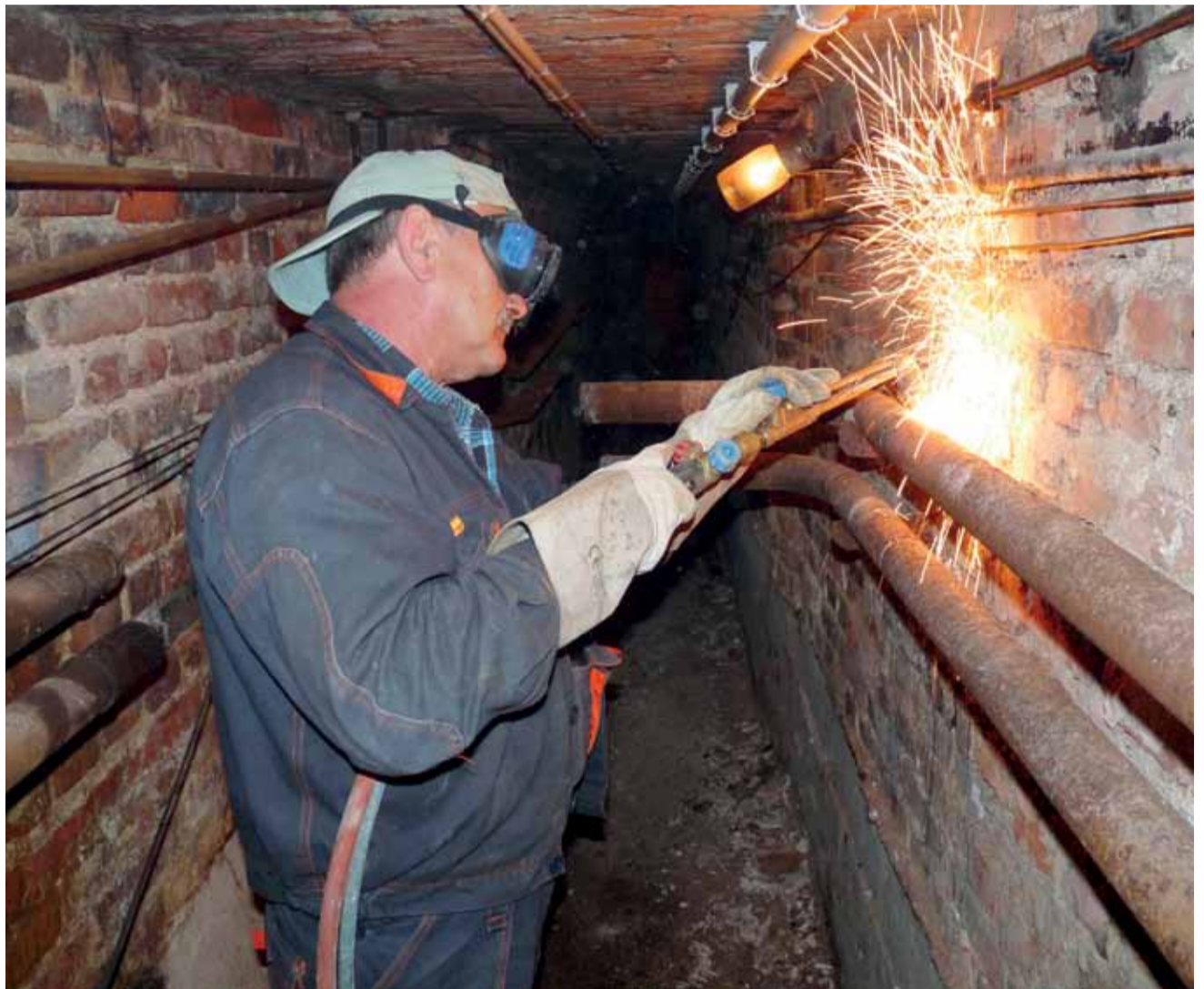
Piwnice pod muzeum. Leszek Budzałek demontuje stary system centralnego ogrzewania.
