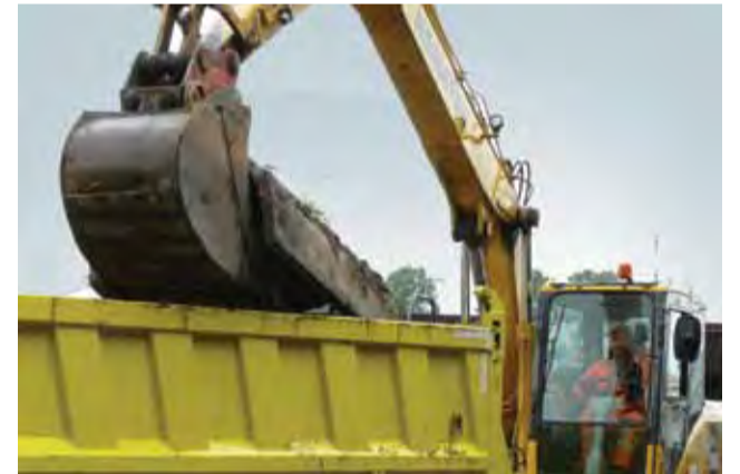
Koparka ładuje jedną z ostatnich betonowych osłon, zdemontowanego ciepłociągu z ul. Sikorskiego.
