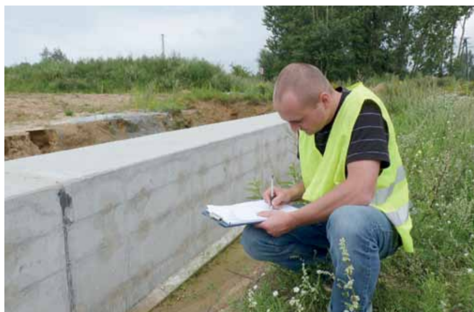
Aleksander Czolnik, inżynier budowy z piotrkowskiej firmy Madej, sprawdza warunki, w jakich nowemu wykonawcy przyjdzie kontynuować budowę A-2 pod Dmosinem.
