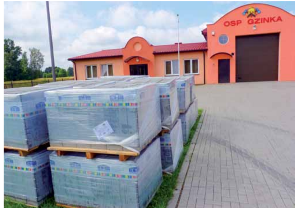
Kostka na budowę parkingu już stoi na terenie OSP.
