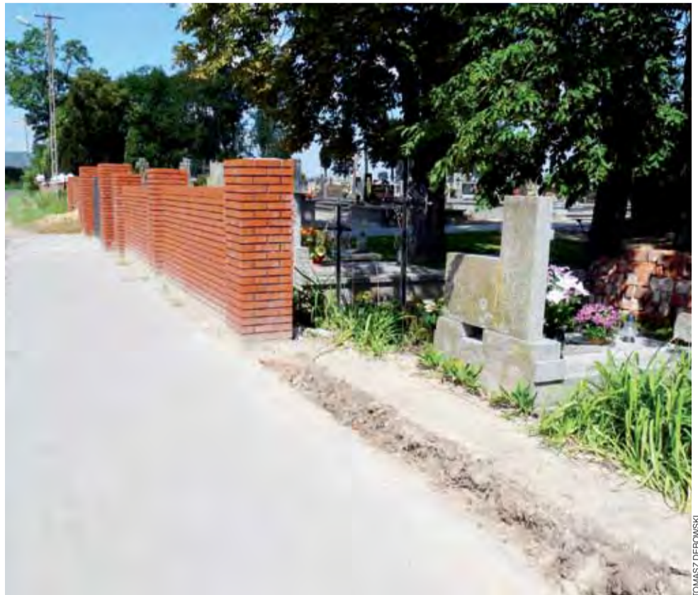
Część muru została postawiona w roku ubiegłym. Pozostała część ma być gotowa jeszcze we wrześniu.
