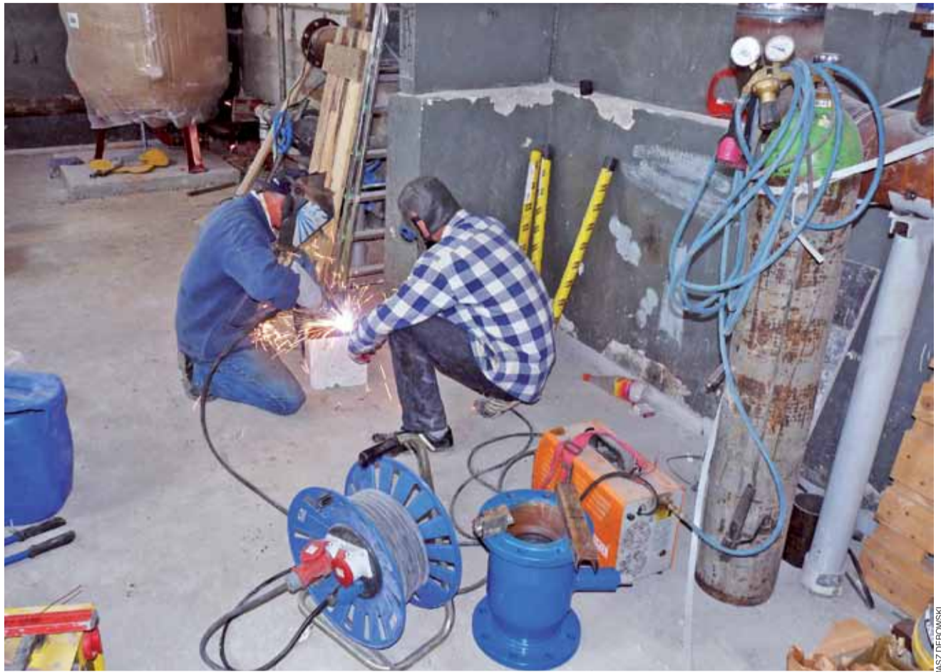
Pracownicy odpowiedzialni za hydraulikę mają sporo pracy. Tu spawają podstawy do pomp.
