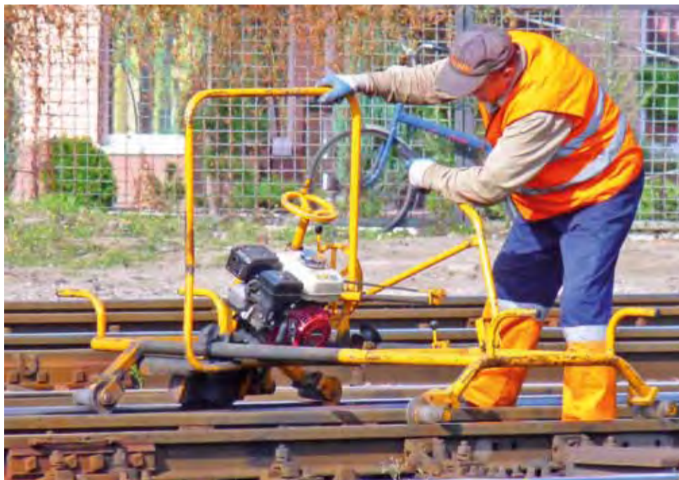
Szlifowanie szyn odbywa się przy wykorzystaniu specjalistycznych urządzeń.
