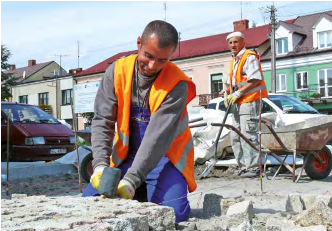
Prace przy układaniu nawierzchni na ul. Bielawskiej w Łowiczu.
