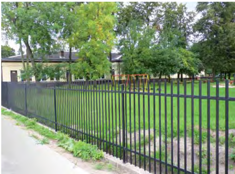
Nowe ogrodzenie Przedszkola nr 5 od strony ul. Piekarskiej.
