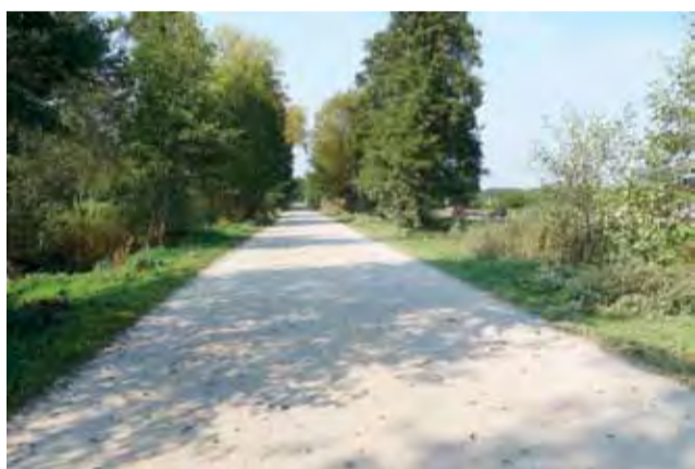
Obecnie Trakt Zielkowicki jest drogą rzadko uczęszczaną ze względu na to, że nie jest utwardzony masą bitumiczną lecz tłuczniem.
