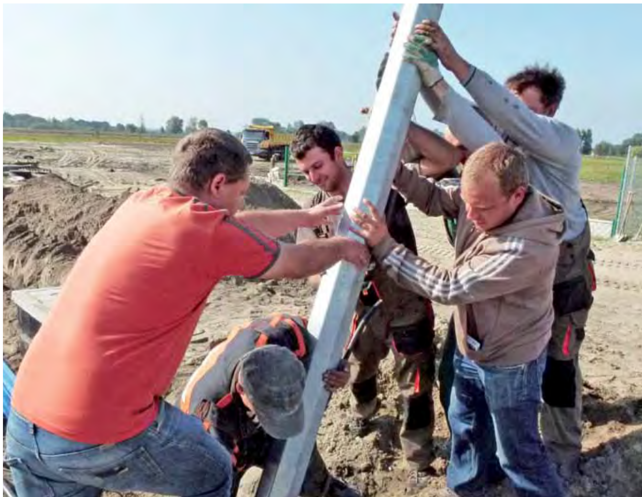
Jednym z ostatnich elementów prac na ul. Ekonomicznej było ustawienie lamp oświetlenia ulicznego.
