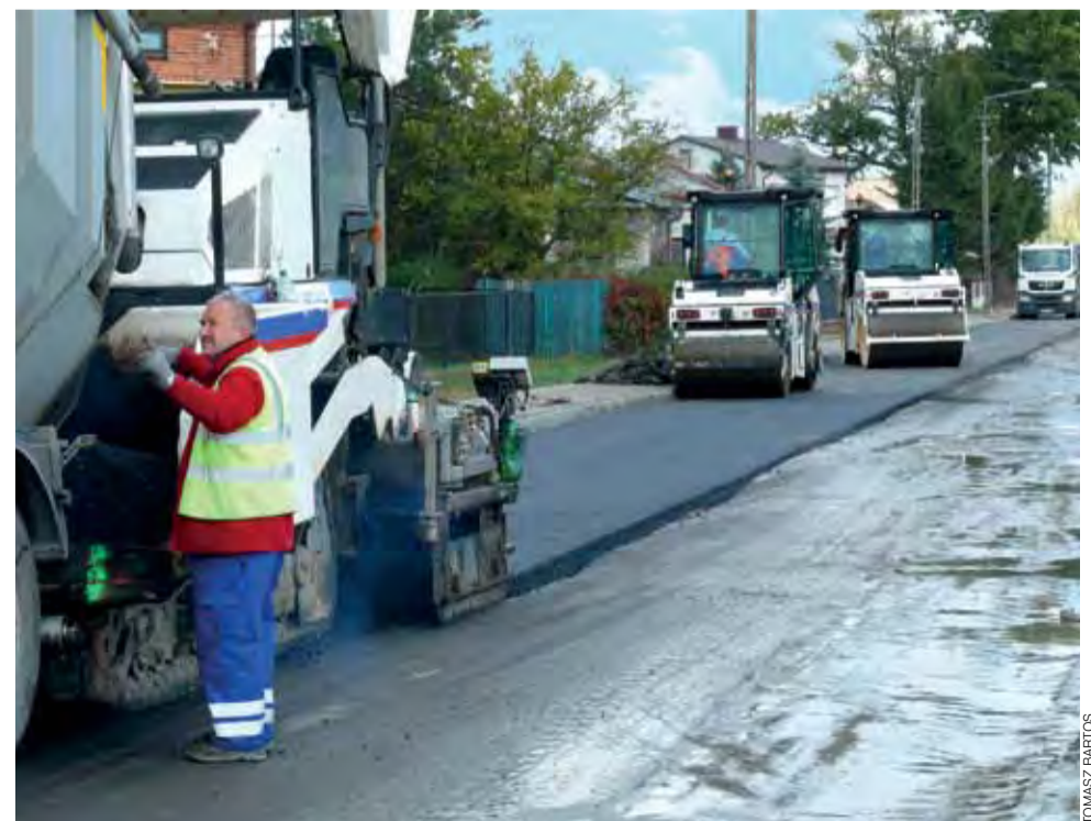
Na ul. Chełmońskiego trwa układanie pierwszej warstwy asfaltu, oznacza to koniec dziur, do których przyzwyczailiśmy się przez ostatnie 3 lata.
