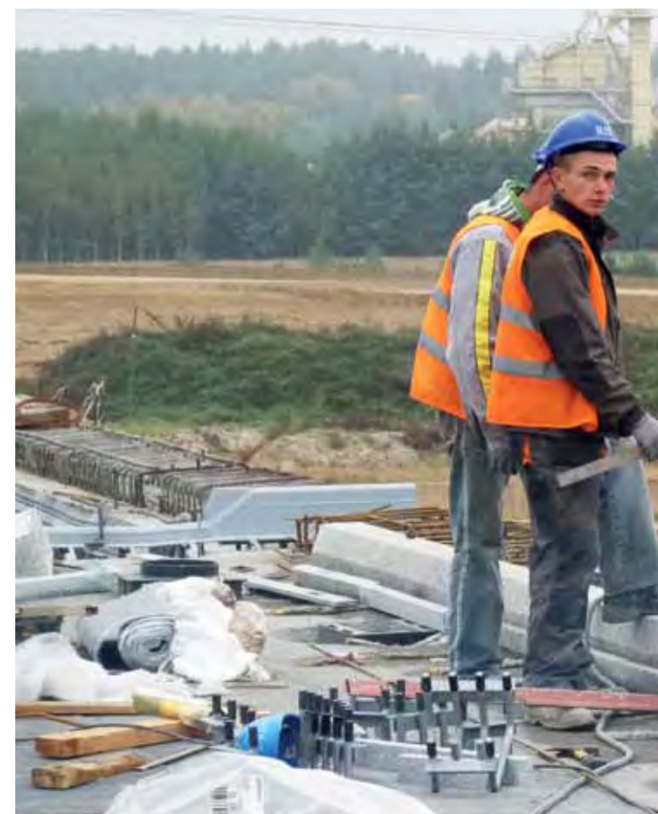
Na budowie autostrady pracuje też wielu młodych ludzi. Na zdjęciu pracownicy przy budowie estakady węzła „Skierniewice” w okolicach Nieborowa, na skrzyżowaniu drogi Łowicz-Skierniewice.
