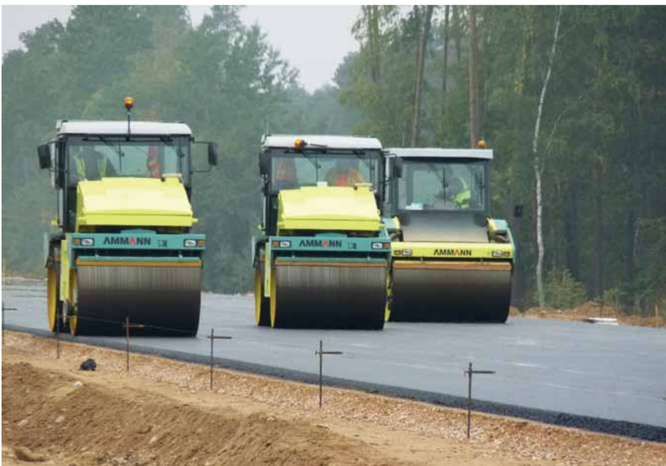
Grupa walców wyrównuje nowo kładzoną nawierzchnię mniej więcej w połowie odcinka B.
