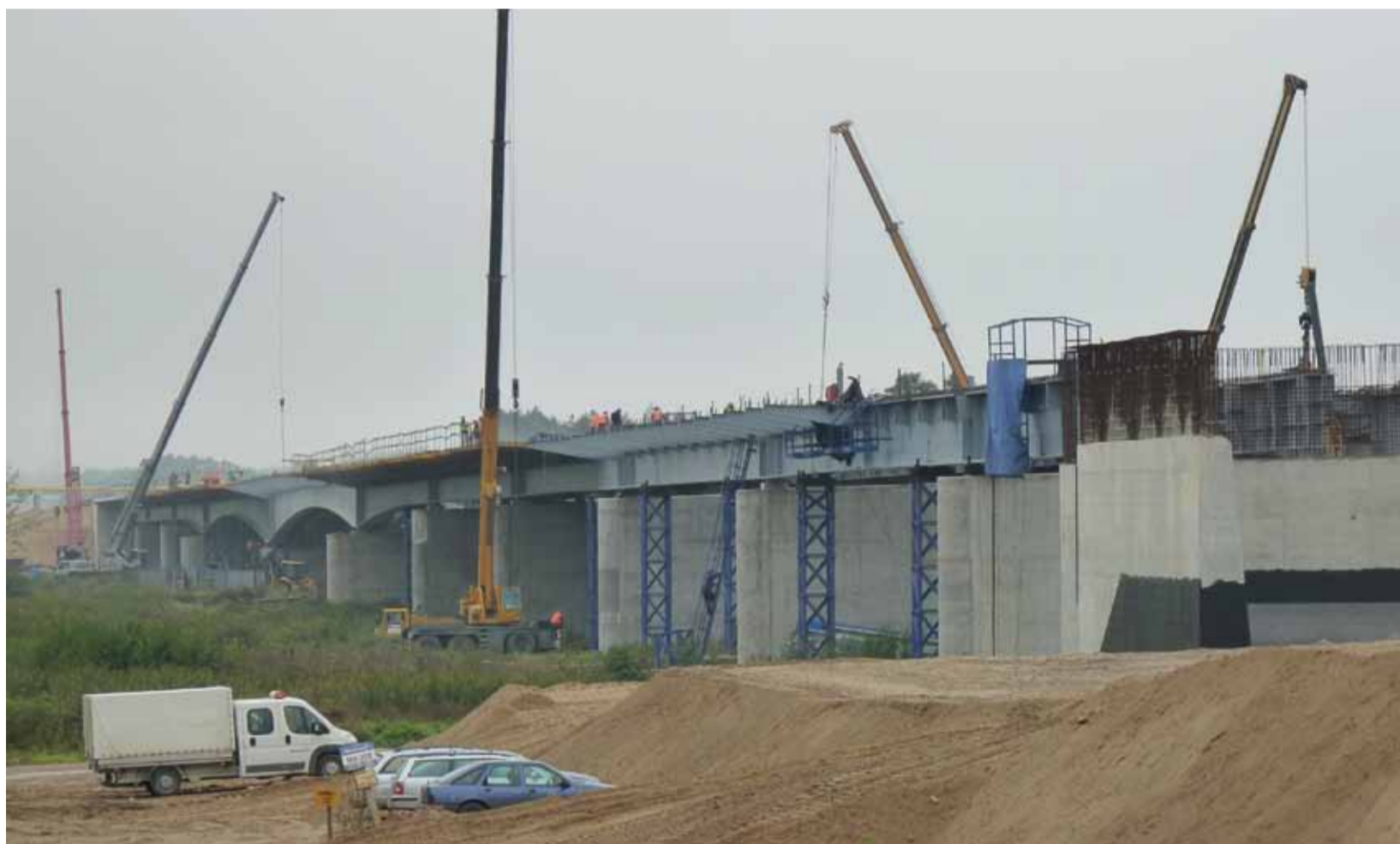
Most nad Rawką, tutaj sfotografowany od strony Woli Szydłowieckiej, jest imponującą budowlą. Przy jego budowie pracuje ciągle kilka dźwigów.
