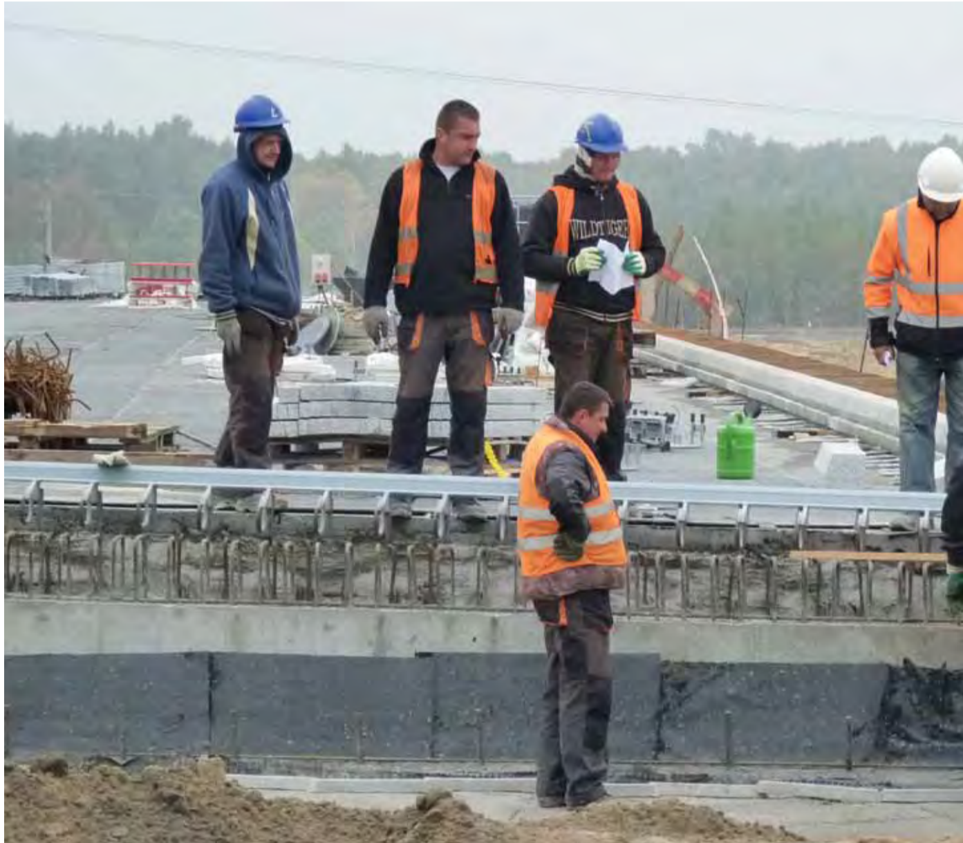
Na budowie pracuje blisko tysiąc osób. Tutaj pracownicy przy budowie estakady węzła „Skierniewice” w okolicach Nieborowa, na skrzyżowaniu drogi Łowicz-Skierniewice.
