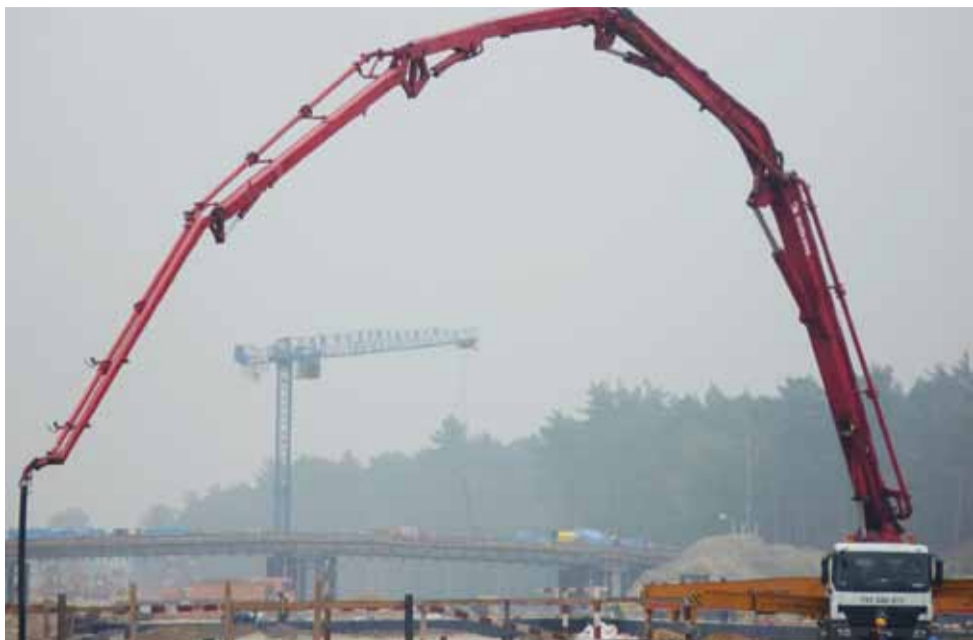
Niektóre widoki na autostradzie, tak jak ten uwieczniony w połowie odcinka budowy moment wylewania betonu, są bardzo malownicze.
