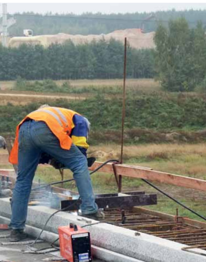
spawający elementy na budowie estakady węzła Skierniewice.
