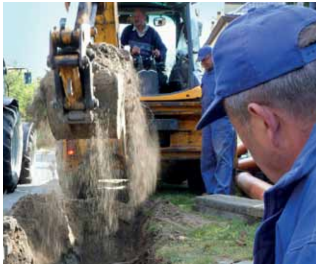
Naprawa kanalizacji deszczowej w ul. Starościńskiej polegała na wymianie starych betonowych rur na rury z PCV.
