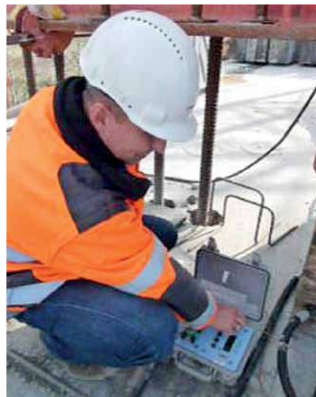
Kierownik Tomasz Szymański sprawdza wytrzymałość betonu. Urządzenie systemu Con-Reg pozwala ją mierzyć na bieżąco, a skład użytej mieszanki gwarantuje, że beton już po upływie 36 godzin osiąga wytrzymałość umożliwiającą naciąganie kabli.
