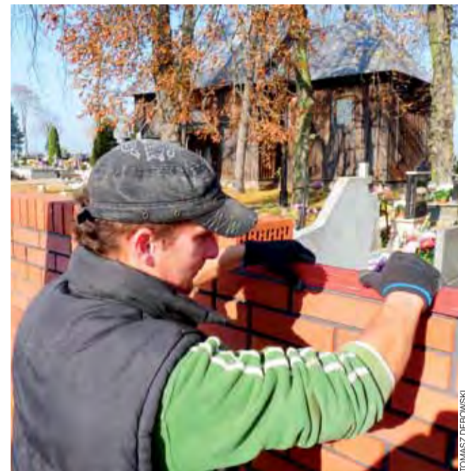
W ubiegłym tygodniu przeprowadzono końcowe prace. Kładziono ostatnie cegły.
