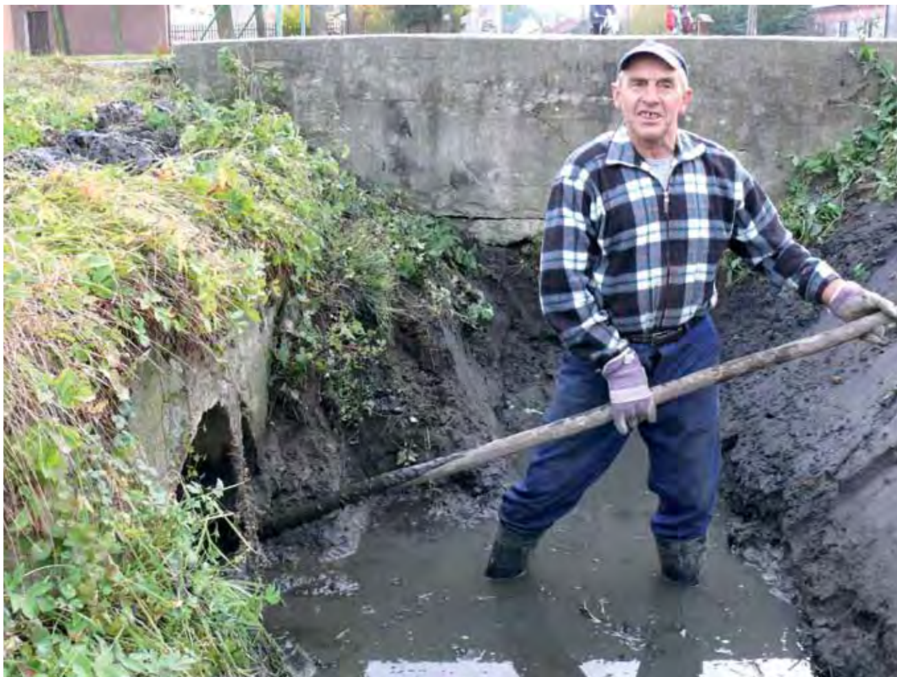
Stanisław Zawisłak przy pomocy topaty zamocowanej na długim drągu oczyszcza kolektor odprowadzający wodę do przydrożnego rowu.
