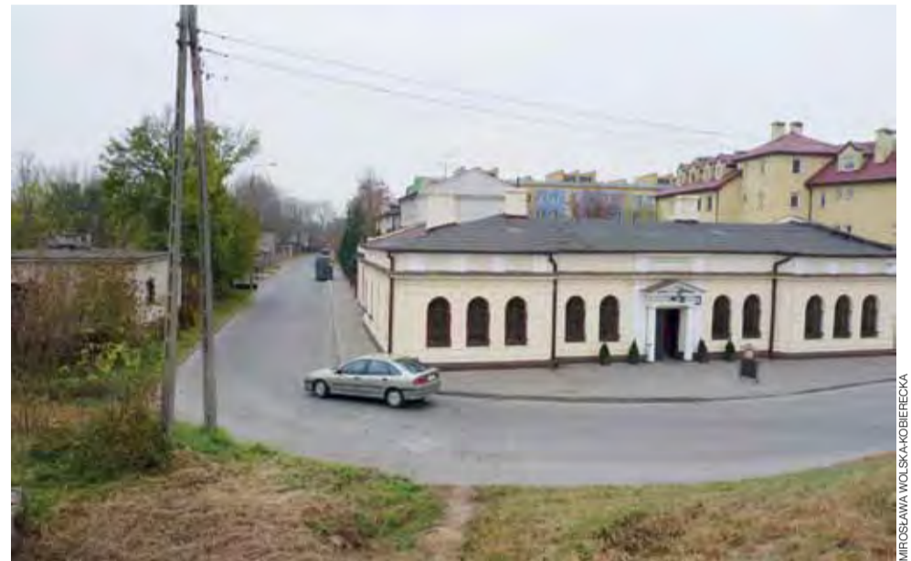
Zakręt na ul. Tkaczew przy dawnej łaźni dobrze widoczny jest dopiero po wejściu na kolejową skarpe. Dla pieszych i kierowców to miejsce nie jest bezpieczne.
