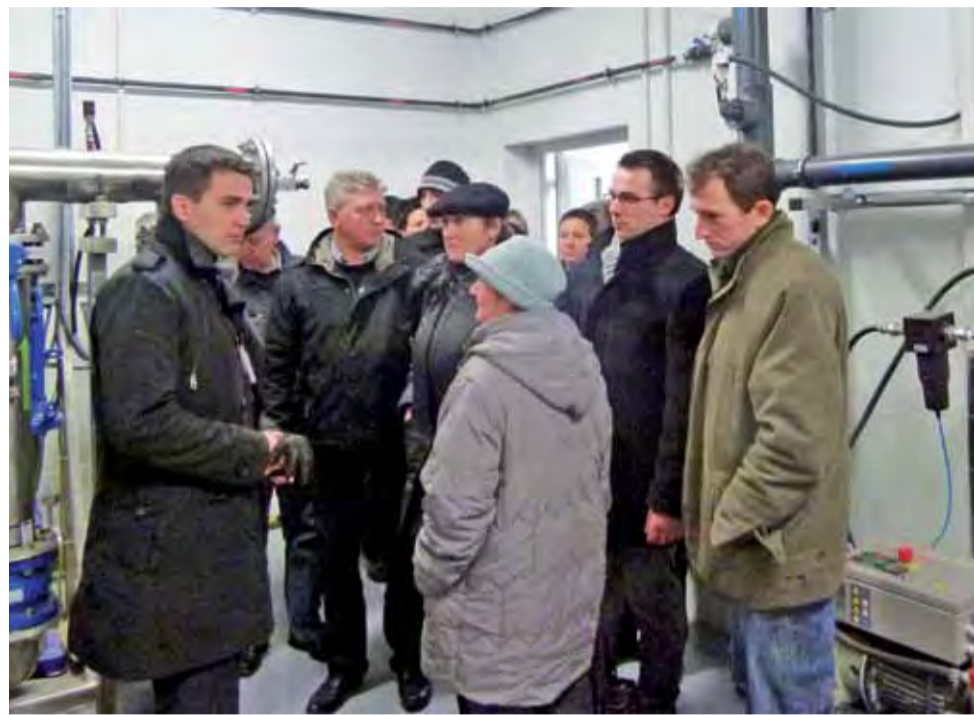
Wójt Dariusz Reczulski oprowadza radnych po budynku nowej hydroforni.
