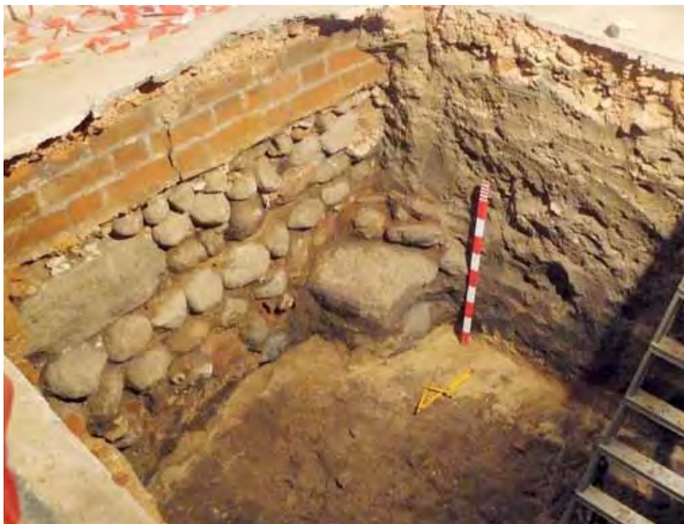
Ława fundamentowa nawy bocznej kolegiaty.
