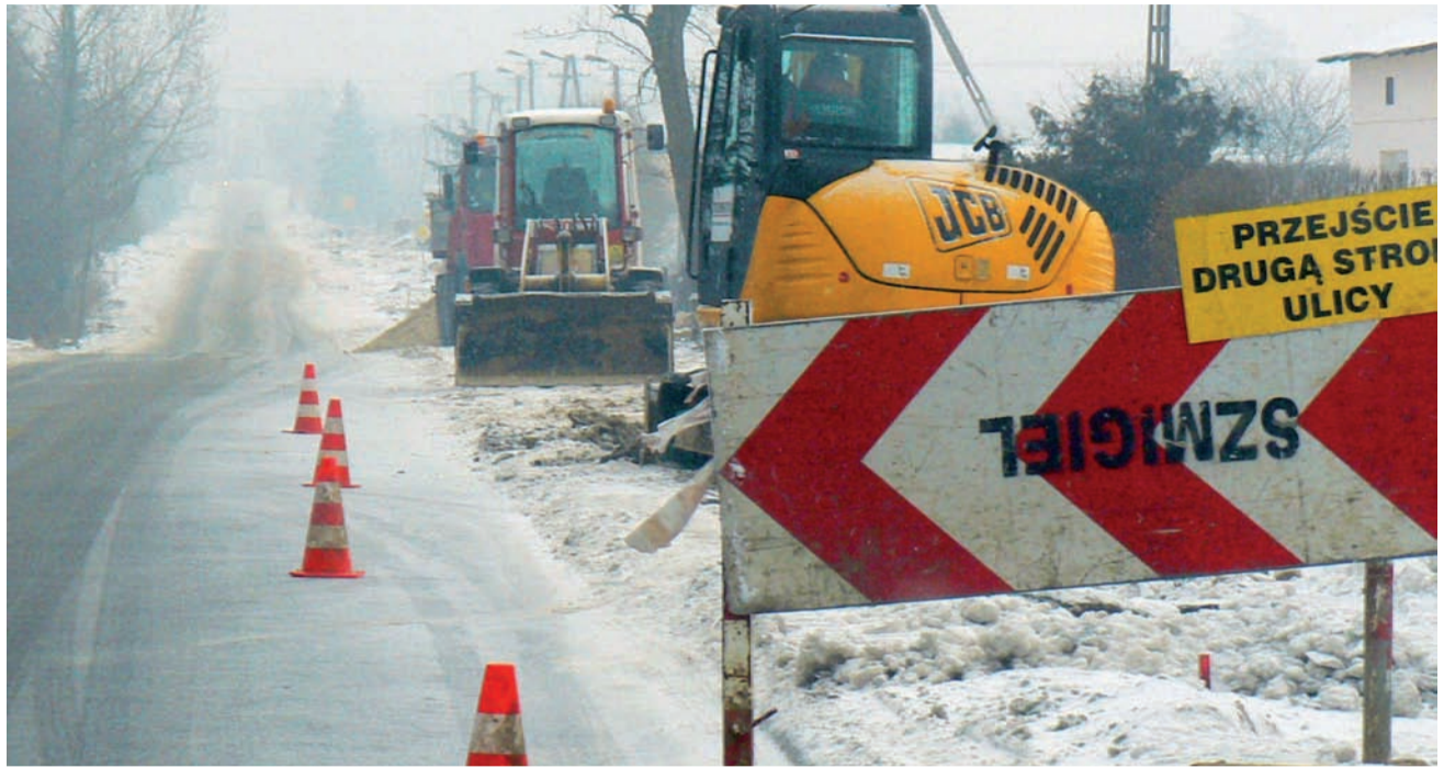
29 grudnia. Budowa kanalizacji w Dmosinie Drugim.
