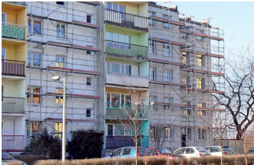
W tym roku prace dociepleniowe mają ograniczyć się tylko do dokończenia docieplenia bloku nr 12 na osiedlu Kopernika.
