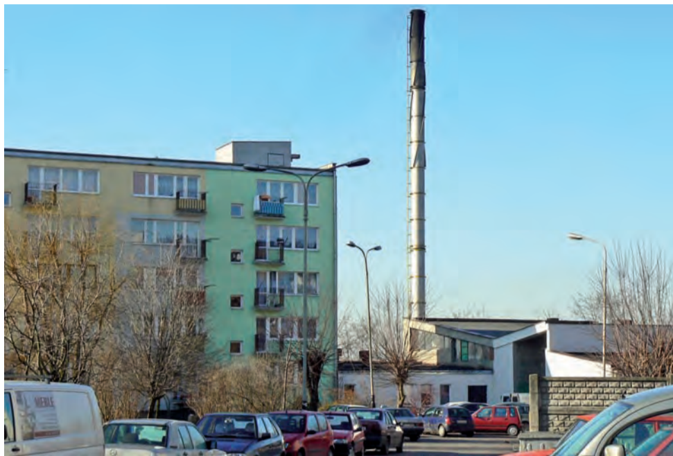
Sadza podobna do tej, która osadziła się na samym kominie kotłowni osadza się także na oknach i balkonach okolicznych bloków.
