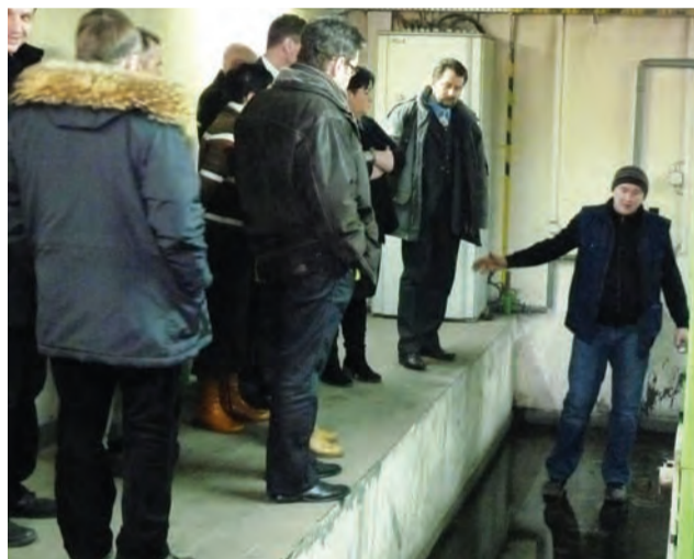
Po kotłowni szkolnej oprowadzał radnych miejskich z komisji oświatowej palacz Przemysław Kwiatkowski.
