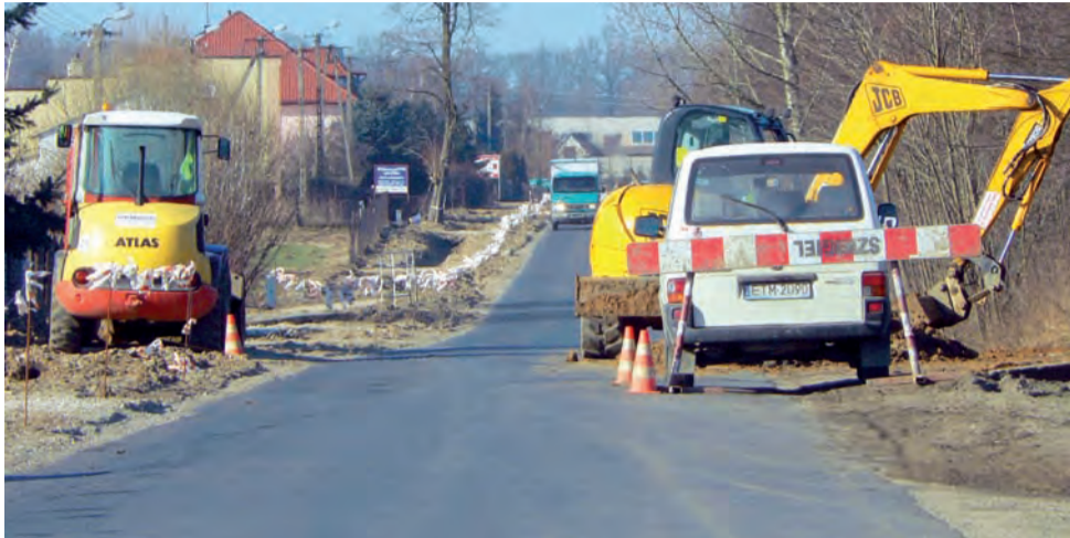
W tym roku gmina Dmosin m.in. kontynuować będzie budowę kanalizacji sanitarnej wraz z przyłączami w Dmosinie, Dmosinie Pierwszym i Drugim.
