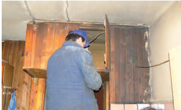
To w tym drewnianym pawlaczu znajdował się otwór do kanału wentylacyjnego, który okazał się również kanałem dymowym.
