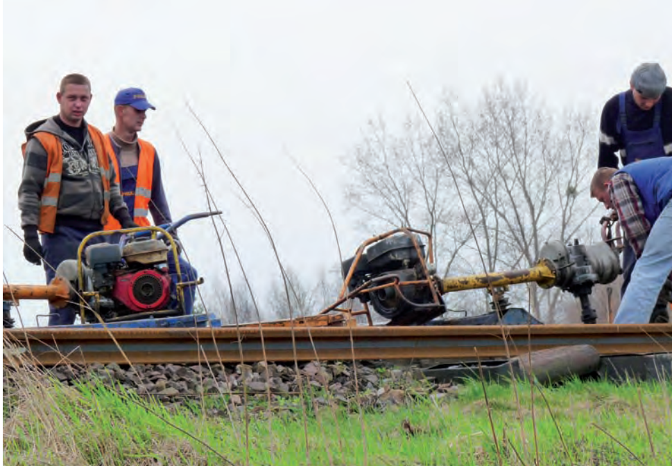
Roboty przygotowawcze w obrębie przejazdu na ul. Kolejowej trwały już od początku tygodnia.
