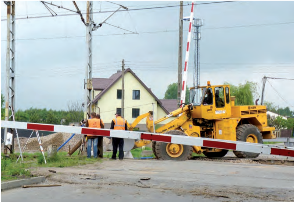
Liczna ekipa robotników i duża ilość maszyn dają nadzieję, że remont przejazdu w kierunku Tymianki przebiegnie sprawnie.
