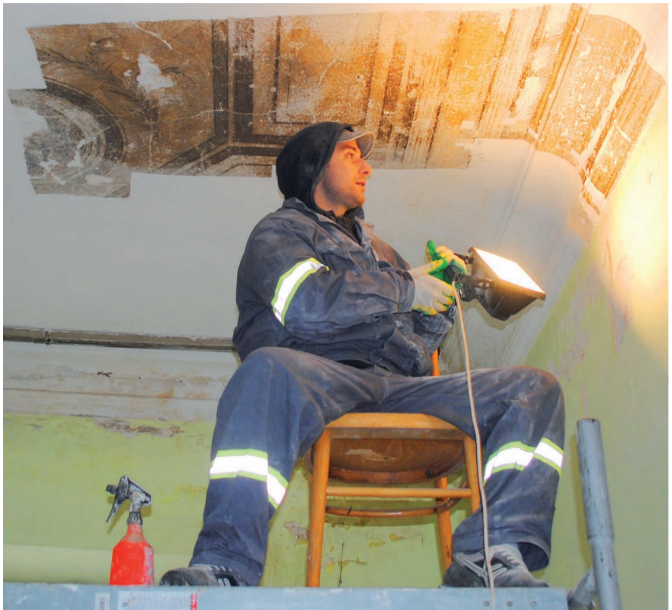
Jeden z konserwatorów w czasie odświeżania polichromii, ukrytej pod warstwami farby w sannickim pałacu.
