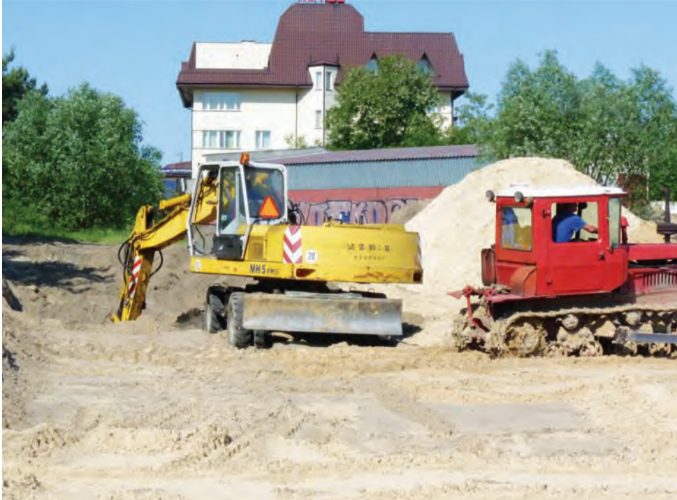
Na miejscu pracuje sprzęt MZWIK oraz prywatnej firmy Wodociągi i Kanalizacji Krzysztofa Kucińskiego.
