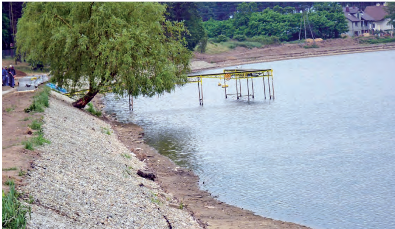
Skarpy umocnione grysem i geokratą dodatkowo zabezpieczono warstwą betonu.
