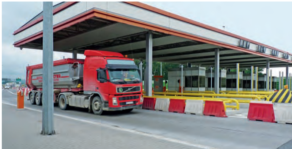
Wjazd na autostradę w Strykowie. Bramki jeszcze otwarte na oścież.
