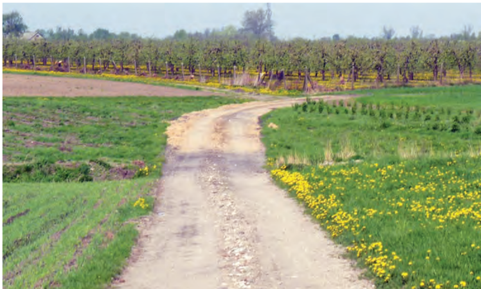
Drogi gruntowe na terenie gminy Głowno. Na zdjęciu – okolice Ostrołęki.
