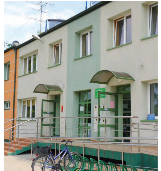
Na parterze tego budynku od wielu lat mieści się ośrodek zdrowia. Na piętrze znajdują się lokale mieszkalne.
