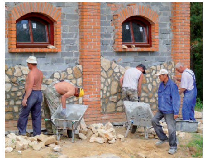
W końcu minionego tygodnia, 8 lipca, ekipa budowlana m.in. wykladała kamieniem piaskowym elewację frontową stajni.
