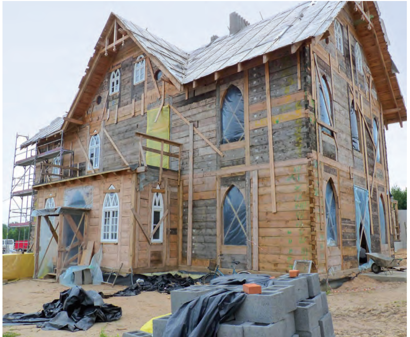
W otworach budynku stylizowanego na kościółek z Ciołka pojawiły się już wykonane na zamówienie drewniane okna.
