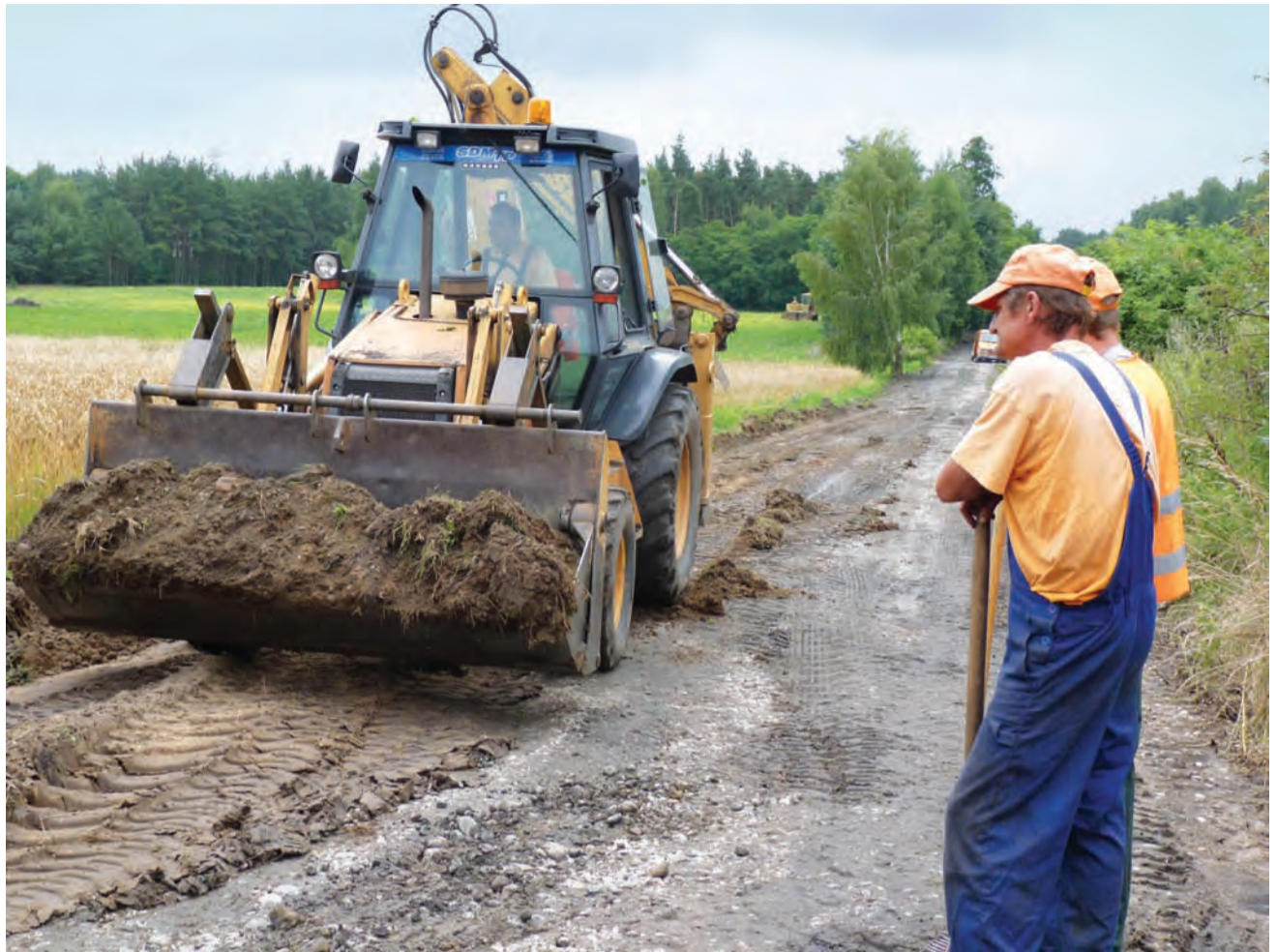
Początek budowy drogi w Rudniczku. Tak przebiegały prace w miniony czwartek, 21 lipca.
