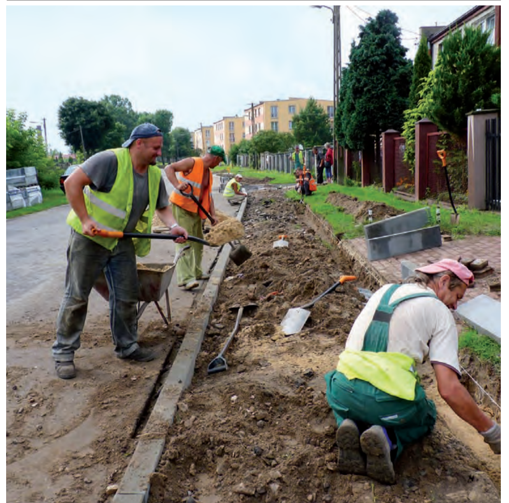
Trwa drugi etap inwestycji wzdłuż ul. Nowości w Bratoszewicach. Łódzka firma Megibud, którą gmina Stryków wybrała w przetargu, kontynuuje rozpoczętą w ubiegłym roku wymianę chodników, zjazdów i krawężników. Prace opóźnia pogoda, ale powinny się zakończyć w przyszłym tygodniu. Wykonawca zainkasuje za nie 144.368 zł. ljs
