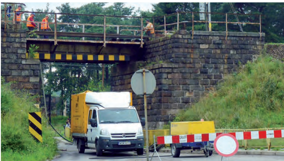
Prowadzony przez Przedsiębiorstwo Napraw Infrastruktury Sp. z o.o. remont torów kolejowych w Głównie utrudnił w dniach 25-27 lipca komunikację w rejonie przejazdu kolejowego w ul. Główniej. Piaskowanie konstrukcji stalowej wiaduktu było przyczyną całkowitego jego zamknięcia dla ruchu kołowego. rpm
