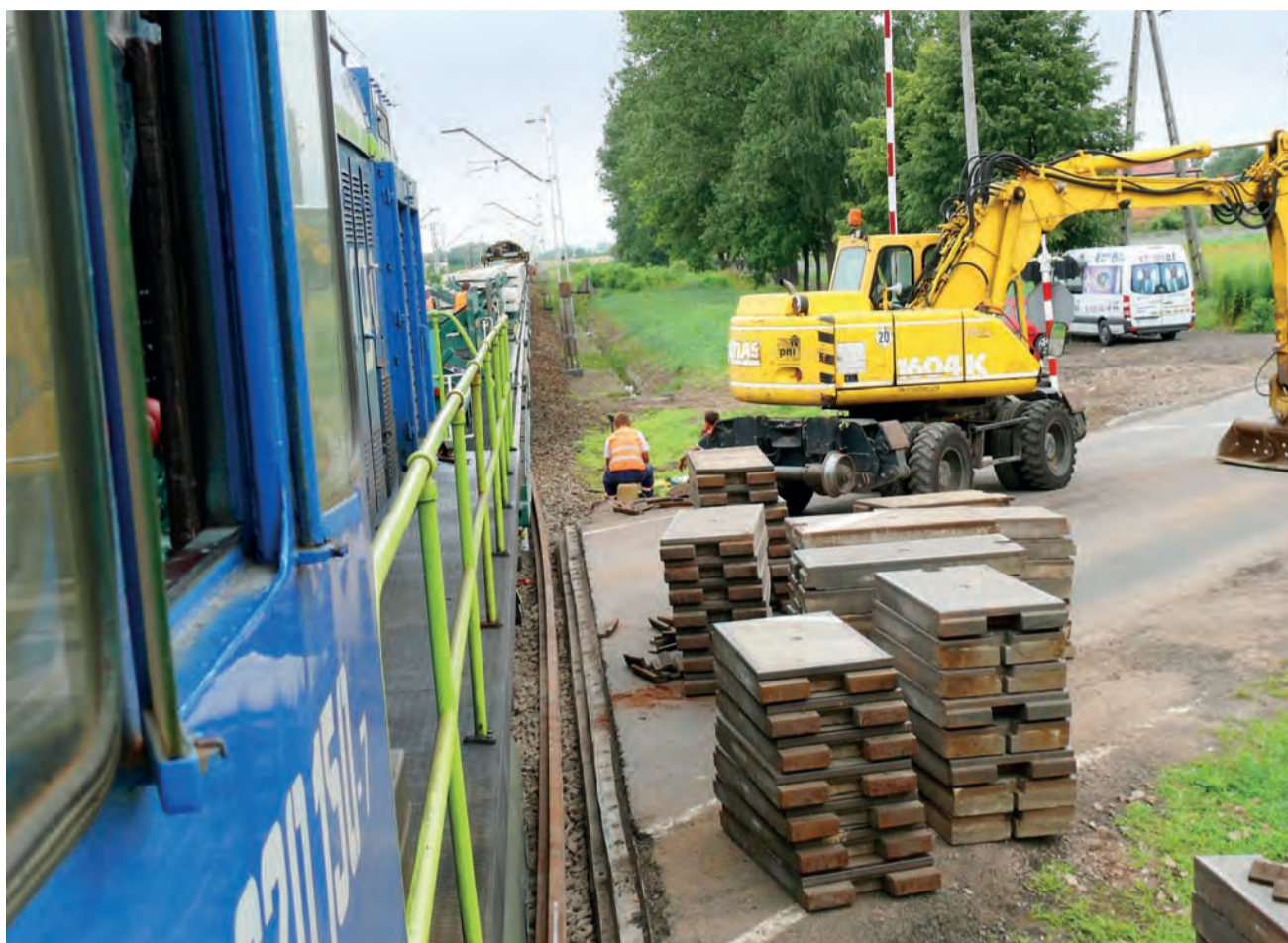
Przełożenie podkładów i torów możliwe jest po zdemontowaniu nawierzchni przejazdów kolejowych. To zdjęcie wykonaliśmy na przejeździe w ul. Seminaryjnej w Łowiczu.
