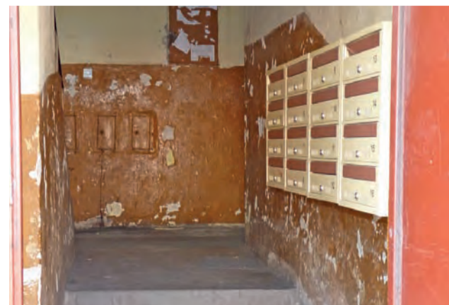
To jest klatka schodowa w budynku komunalnym przy ul. Armii Krajowej, w którym J. otrzymała mieszkanie tymczasowe.
