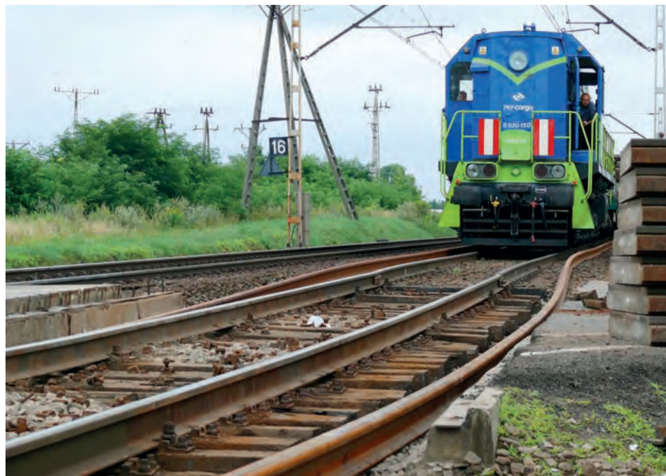
Tamara bardzo często wykorzystywana jest podczas modernizacji torowisk.
