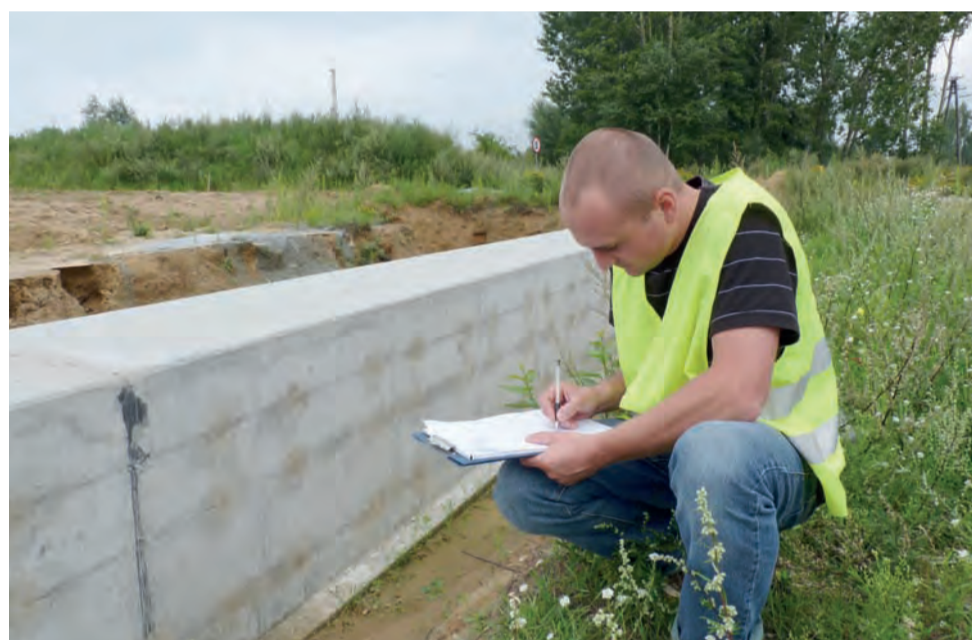
Aleksander Czolińnik, inżynier budowy z piotrkowskiej firmy Madej, sprawdza warunki, w jakich nowemu wykonawcy przyjdzie kontynuować budowę A-2 pod Dmosinem.
