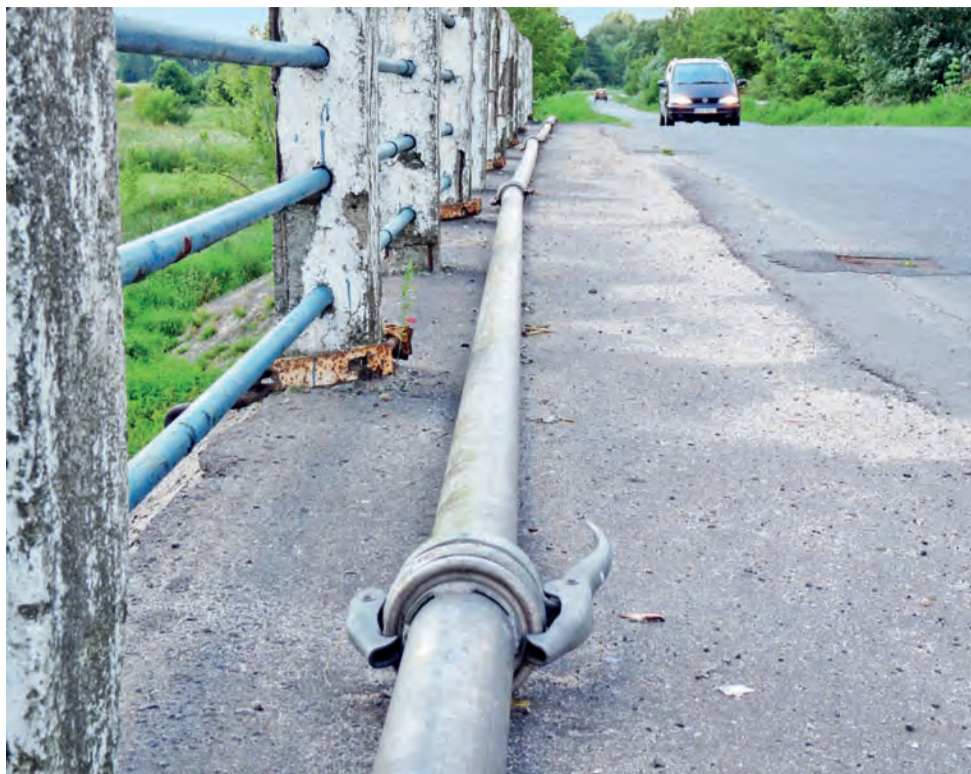
Mieszkańcy Soboty z niecierpliwością czekają na nowy wodociąg. Aktualnie woda jest tłoczona za pomocą rur do deszczowania upraw.
