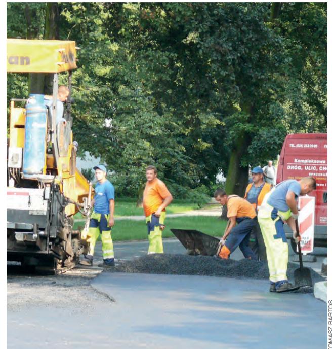
We wtorek i środę asfaltowany był fragment łączący ul. Sikorskiego z Alejami Sienkiewicza.
