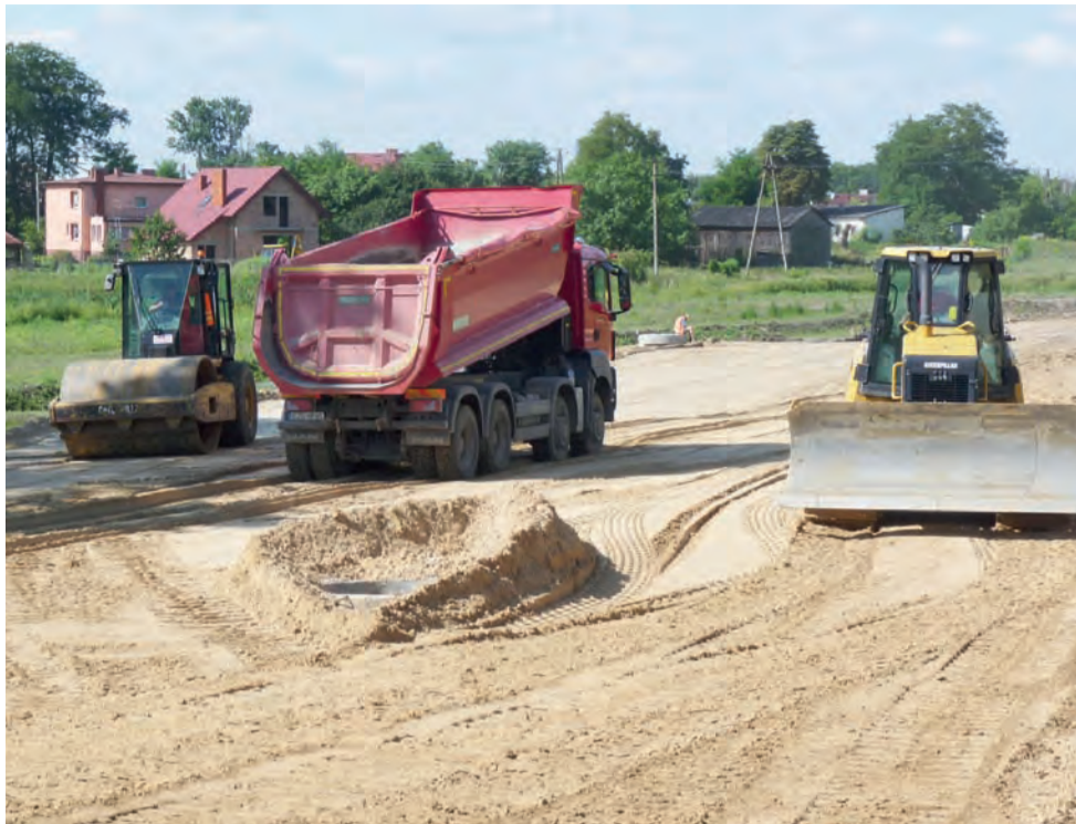
Roboty na odcinku obwodnicy, który będzie łączył się z ul. Ozorkowską. Tutaj kłopotów z podsiąkającą wodą nie widać.
