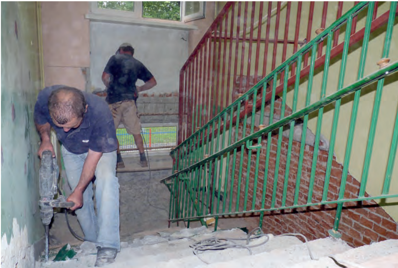
Skuwanie tynku i nawierzchni schodów. Tę ostatnią zastąpić mają płytki antypoślizgowe.
