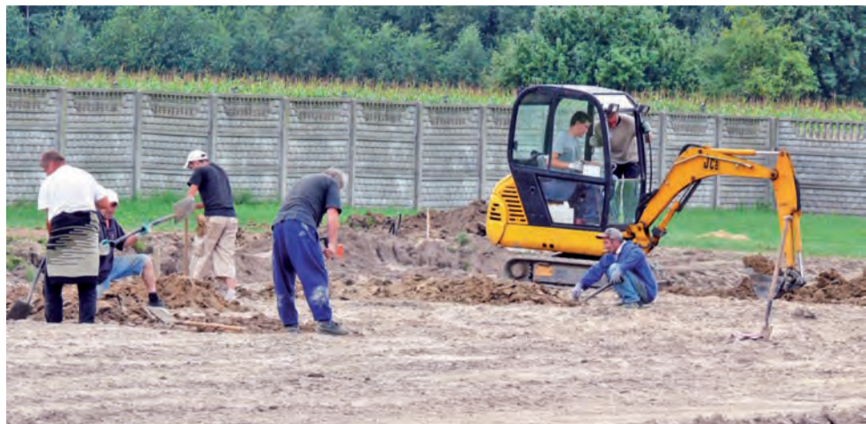
Na placu budowy zespołu boisk przy SP w Bednarach w ubiegłym tygodniu prowadzono roboty ziemne.
