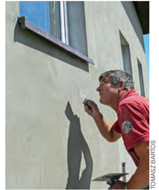
Firma Henryka Szewczyka kończy prace na zewnętrznej elewacji budynku obsadzając parapety.
