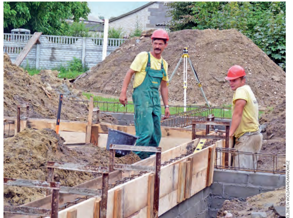
Na budowie. Pracownicy Copper-Polu przy rozbudowie Zespołu Szkół w Popowie Głowieńskim.
