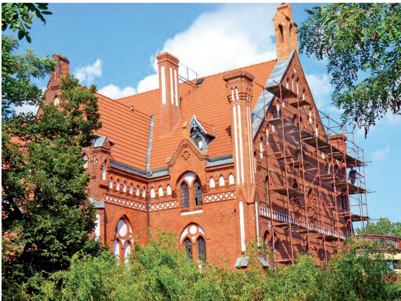
Przy kościele mariawickim trwają ostatnie prace – wykonywane są nowe obróbki blacharskie.
