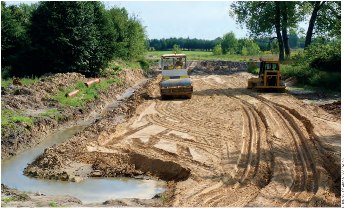
Najbardziej newralgiczny odcinek budowy w okolic ulic Zakładowej i Kolejowej.
