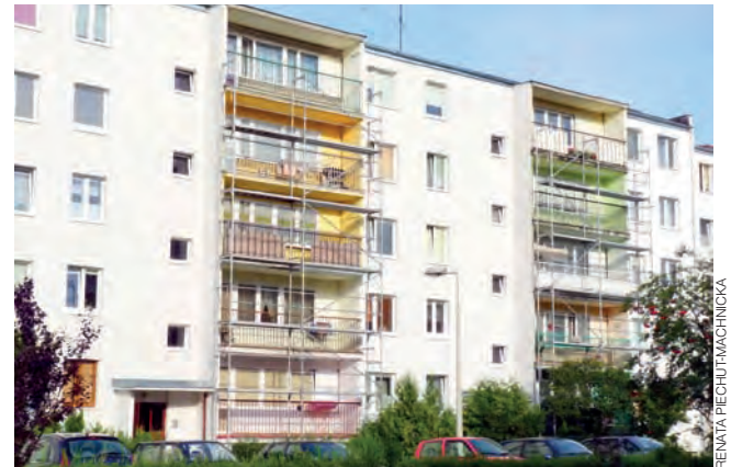
Blok nr 12 na os. Kopernika. Rusztowania przy balkonach już zostały roztawione.
