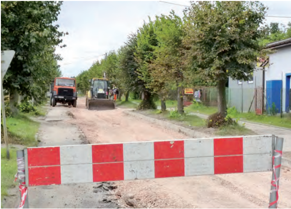
9 września, na ul. Mickiewicza w Głownie ruszyła długo oczekiwana przez mieszkańców odbudowa asfaltowej nawierzchni. Gdy robiliśmy to zdjęcie trwało równanie podbudowy tej ulicy. Prace te wzbudzają kontrowersje.
