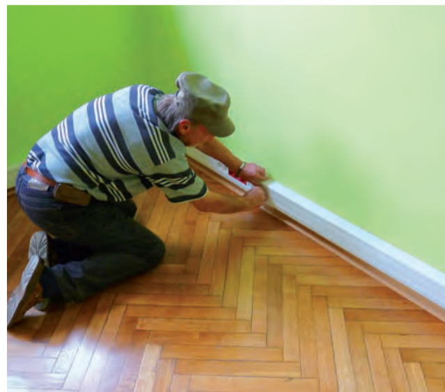
Pracownik Zakładu Obsługi Przedszkoli sprawdza czy listwy zostały dobrze zamontowane.
