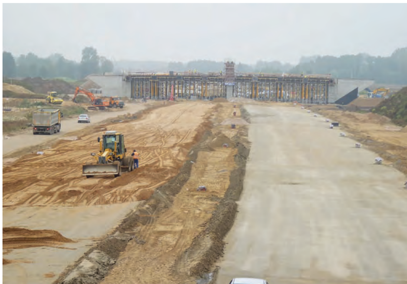
Ze szczytu nowo powstającej estakady trudno ogarnąć wzrokiem całość budowy. W tle powstaje kolejny z obiektów inżynierskich.
