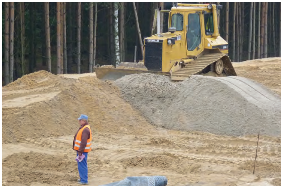
Współpraca ludzi i sprzętu, takiego jak ten spychacz, jest niezbędna. Tutaj w okolicach powstającego mostu kolejowego na początku odcinka B.
