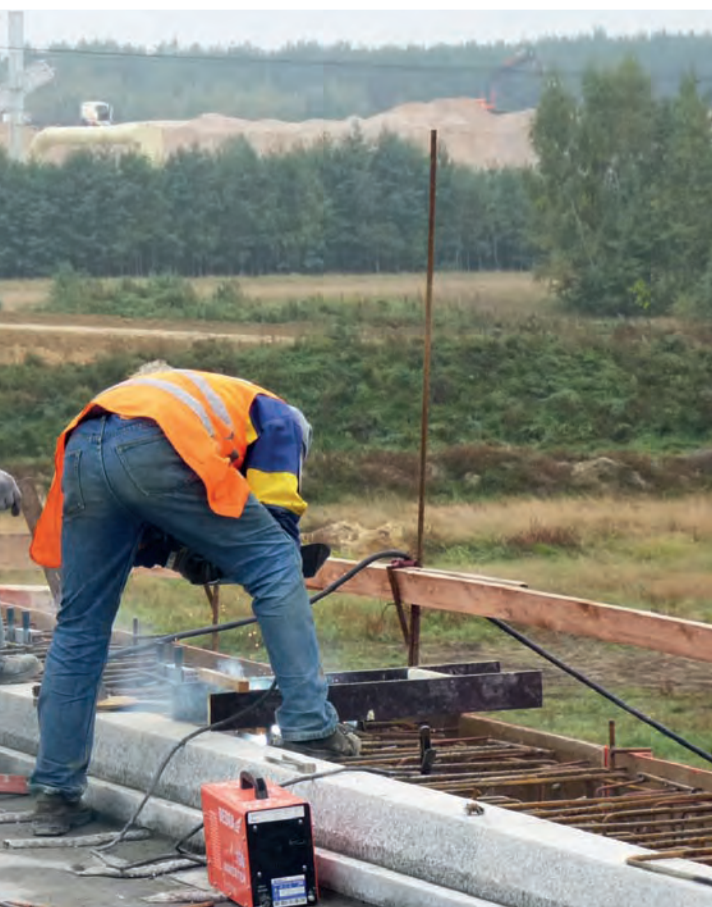
spawający elementy na budowie estakady węzła Skierniewice.
