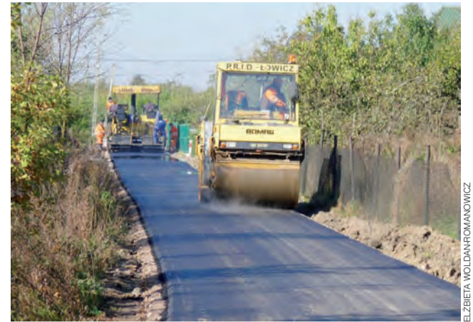
Walcowanie świeżego asfaltu. Roboty prowadzi PRID z Łowicza.
