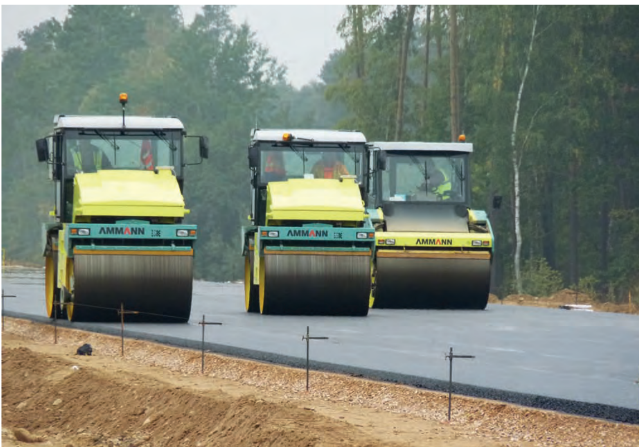
Grupa walców wyrównuje nowo kładzioną nawierzchnię mniej więcej w połowie odcinka B.
