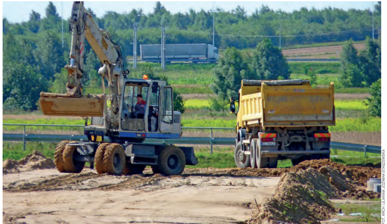
Budowa obwodnicy na tyłach osiedla Zacisze.
