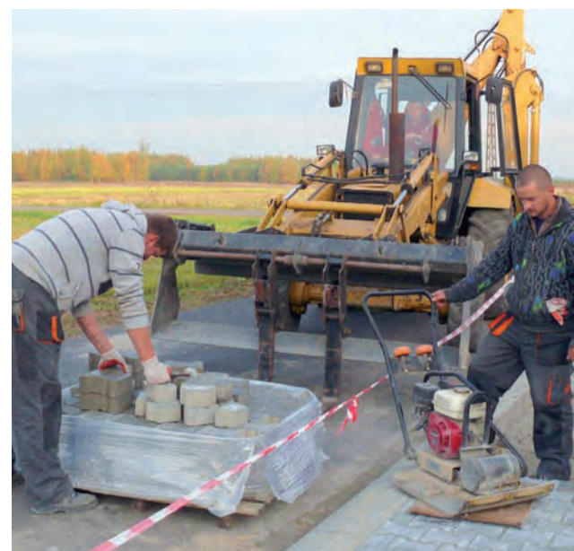
Przy strażnicy OSP w Mysłakowie kończy się budowa chodnika połączony z szerokim podjazdem do garaży.
