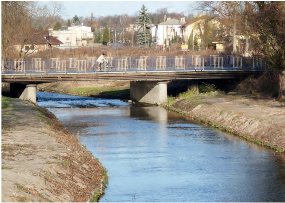
Z brzegów Mrogi usunięto zbędną roślinność oraz zabezpieczono skarpy.
