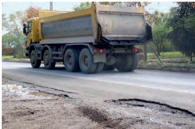
Efekty ruchu samochodów ciężarowych wożących budulec na autostradę najlepiej widać na ul. Batorego w Strykowie.
