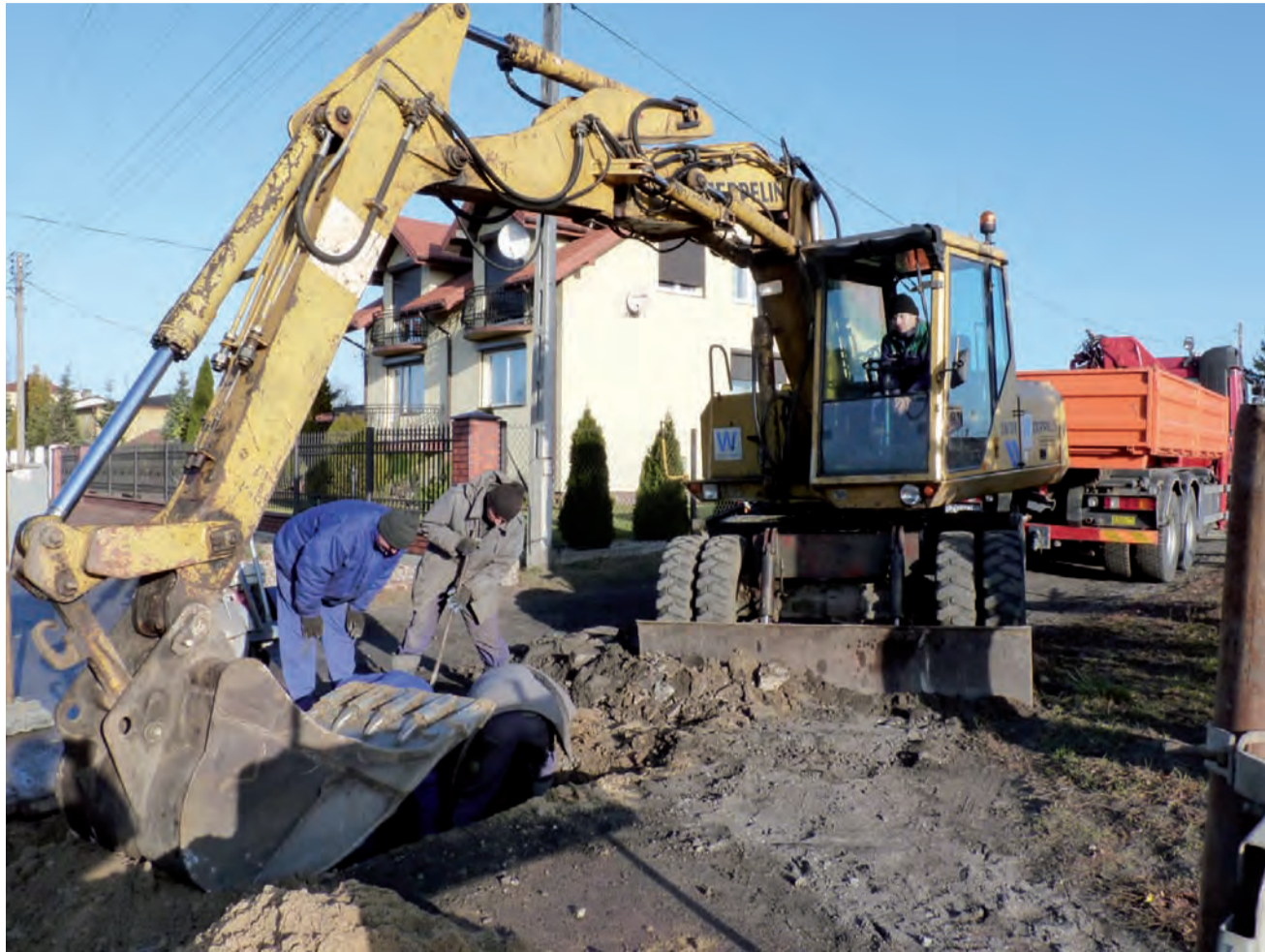
Rozpoczęły się prace przy budowie kanalizacji na 100-metrowym odcinku ul. Rataja.
