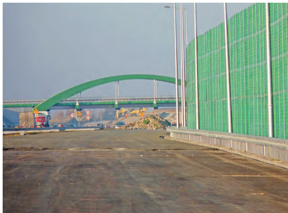
Ekrany akustyczne wzdłuż łącznicy, która teraz stanowi jeszcze tzw. obwodnicę autostradową Strykowa.
