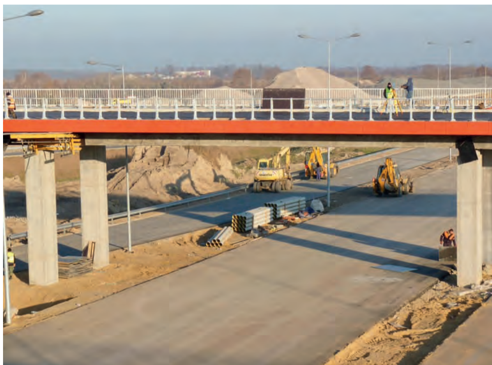
Jeszcze w ubiegłym tygodniu nakładano warstwę ścierną na jednym z fragmentów węzła.
