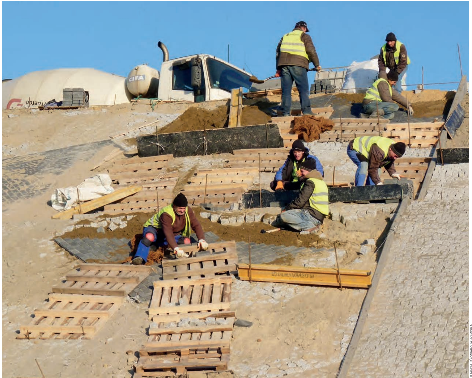
Ostatnie roboty brukarskie na skarpach łącznicy Warszawa – Łódź wykonują lokalni robotnicy.
