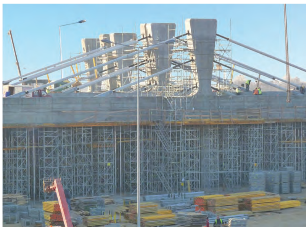
Zwieńczenie węzła, czyli jego główny obiekt krzyżujący autostrady A-1 i A-2.
