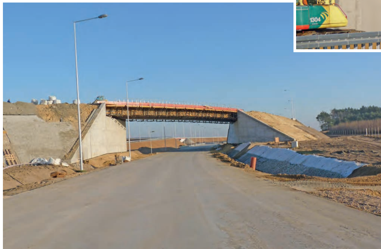
Wiadukt nad łącznicą Poznań – Gdańsk.
