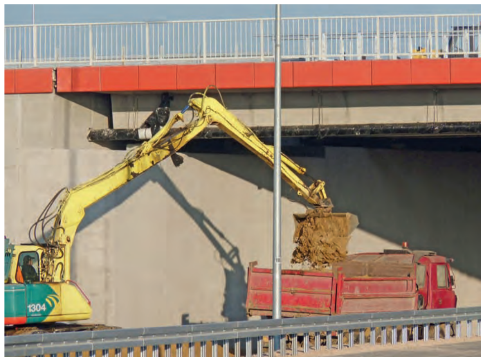
Ostatnie dni robót na węźle poświęcono m.in. na usuwanie hałd humusu, które usypano w niektórych miejscach dla bezpieczeństwa ruchu, na przykład w pobliżu obwodnicy autostradowej Strykowa.
