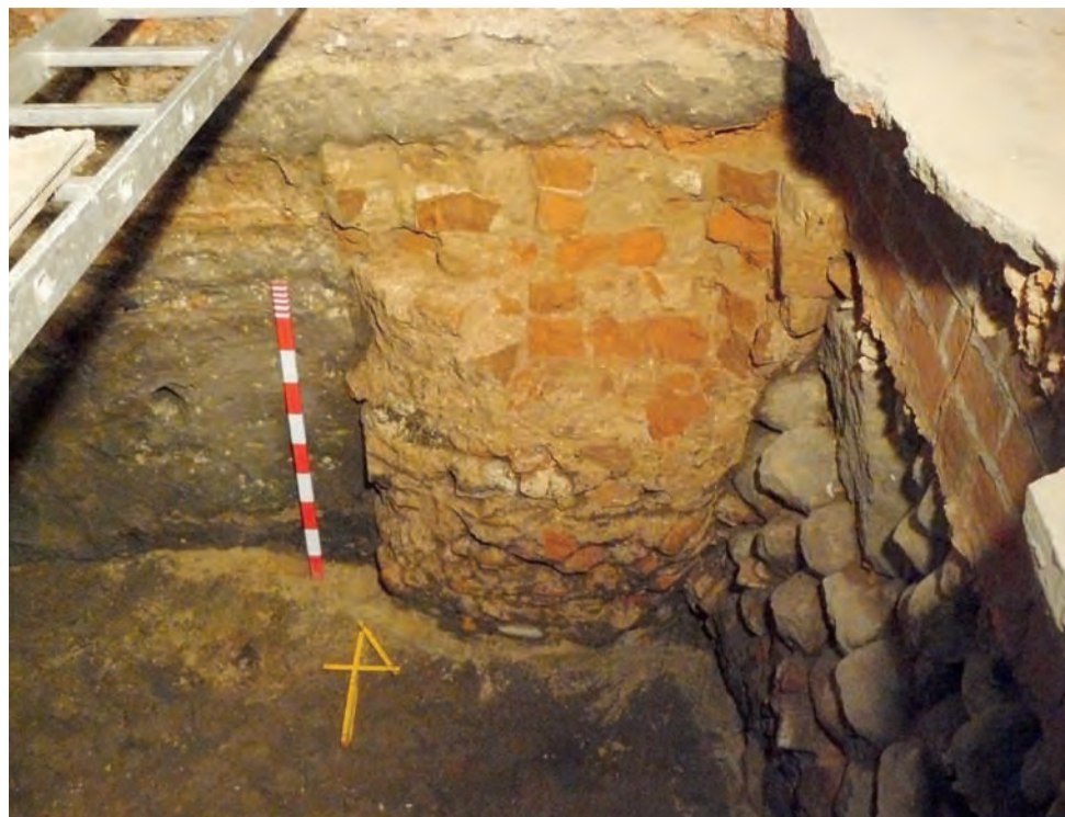
Zachowane relikty okrągłej wieży zlokalizowane w obecnej wieży północnej.
