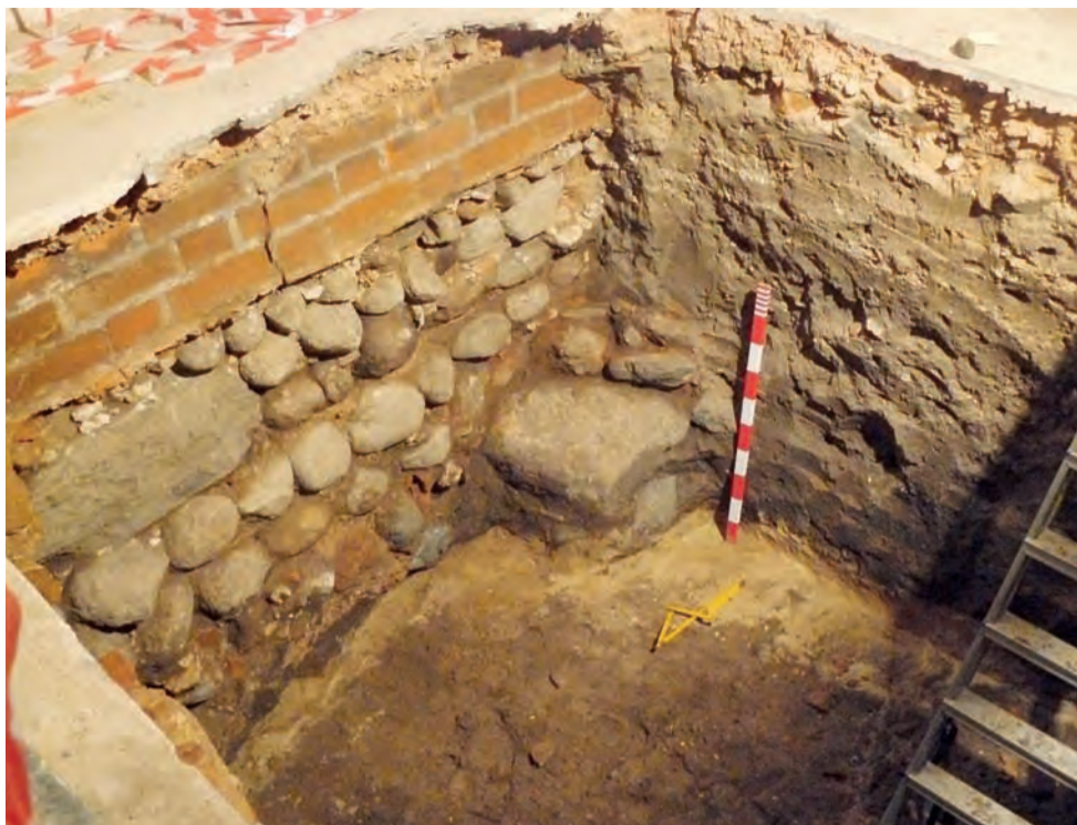
Ława fundamentowa nawy bocznej kolegiaty.
