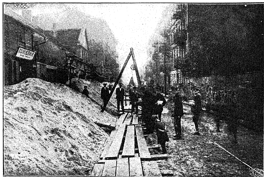
Roboty kanalizacyjne przy ul. Andrzeja posuwają się naprzód.
