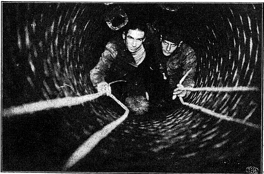
Tunel podziemny na ukończeniu.
