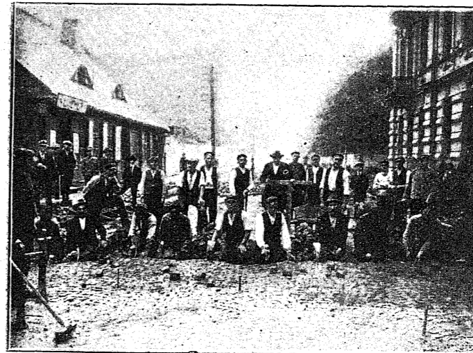
Układanie nowych granitowych jezdni w Łodzi.
